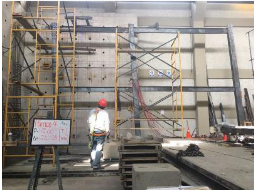
Figura 62. Elementos deformados (-) Elaboración: Jorge Martínez y Darío Pallares
