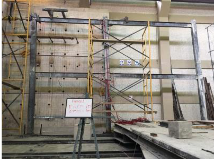
Figura 42. Elementos deformados (-). Elaboración: Jorge Martínez y Darío Pallares
