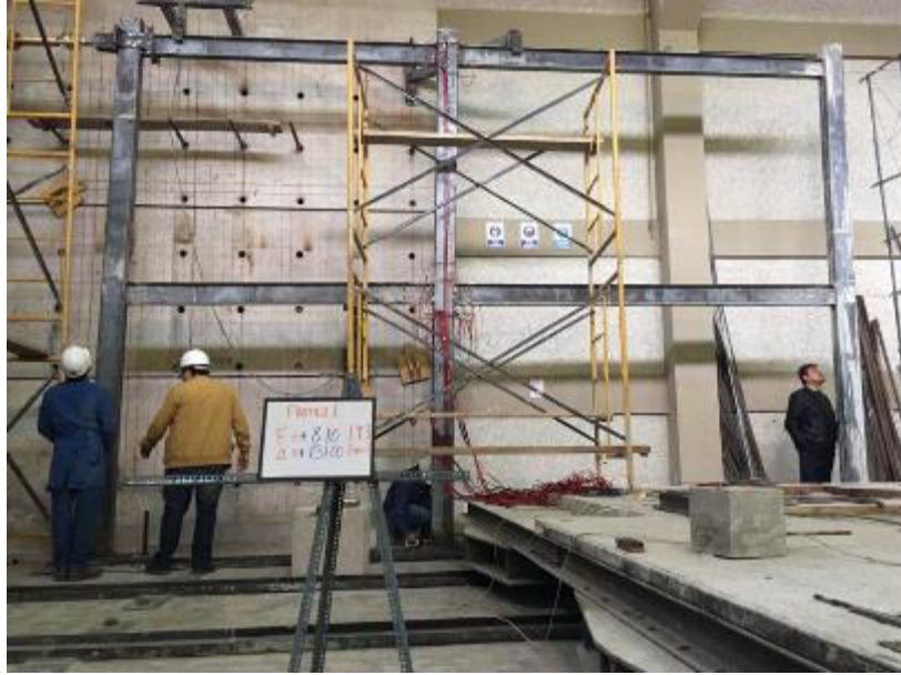
Figura 40. Elementos deformados (+) Elaboración: Jorge Martínez y Darío Pallares
