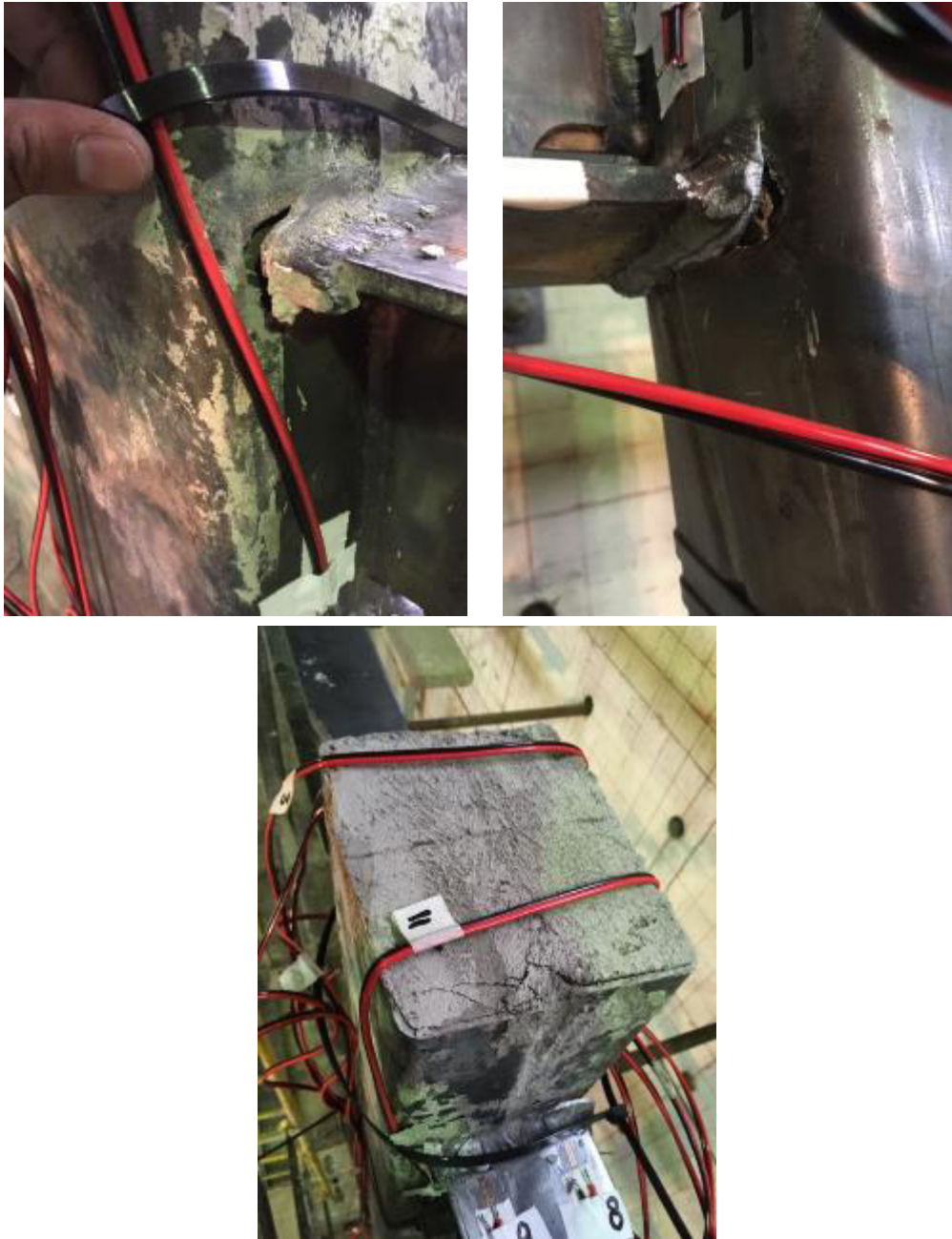
Figura 47. Falla de la conexión. Elaboración: Jorge Martínez y Darío Pallares
