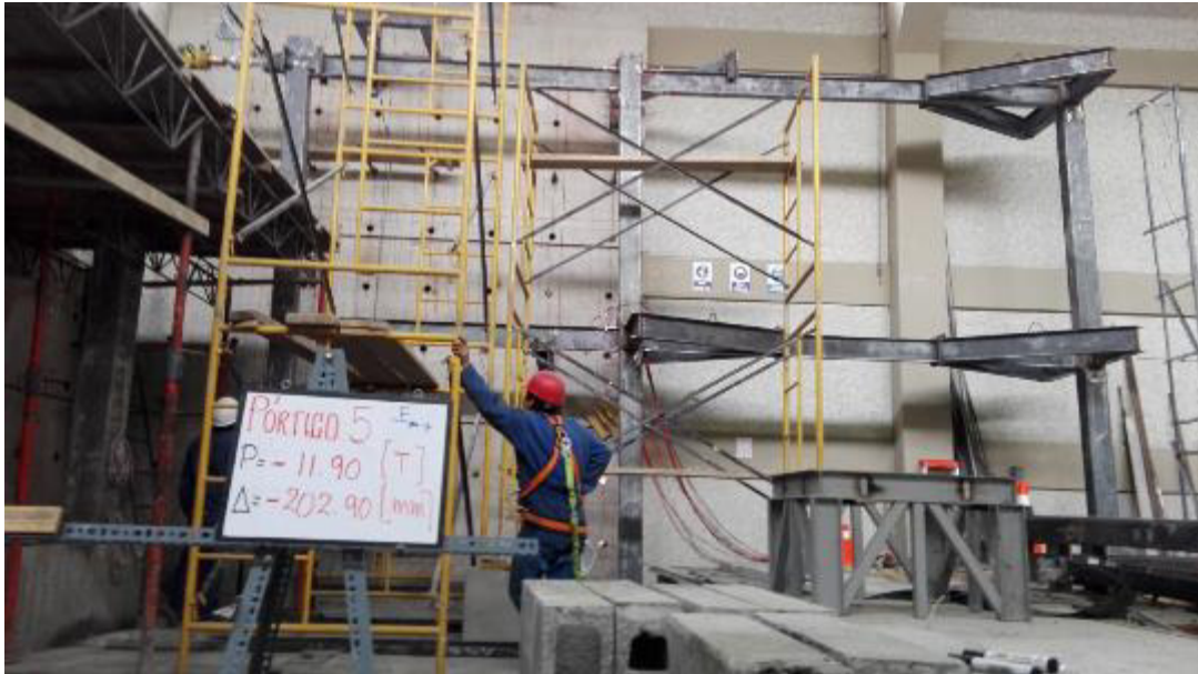
Figura 83. Elementos deformados (-) Elaboración: Jorge Martínez y Darío Pallares
