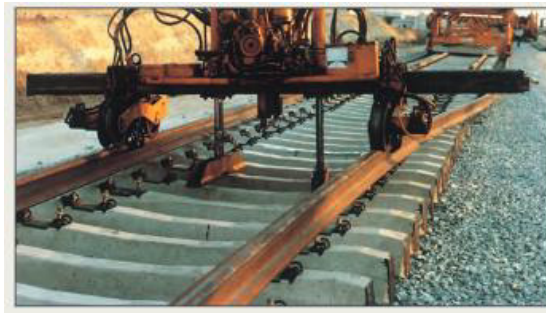
Figura 1.10. Traviesas de hormigón/bloque. (Fuente: ICPA,2013)
