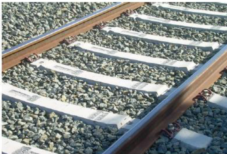
Figura 2.5. Vía convencional, con balasto y traviesas de hormigón monobloque. (Fuente: Zougari, 2014)
