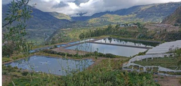
**Figura 6** Lagunas de Oxidación Pelileo.
