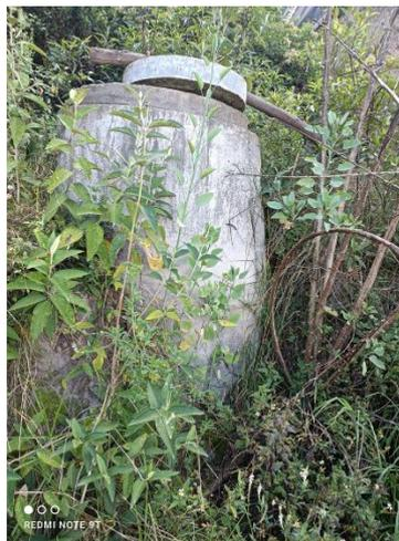
**Figura 10** Tanque actual de almacenamiento de lixiviados.
