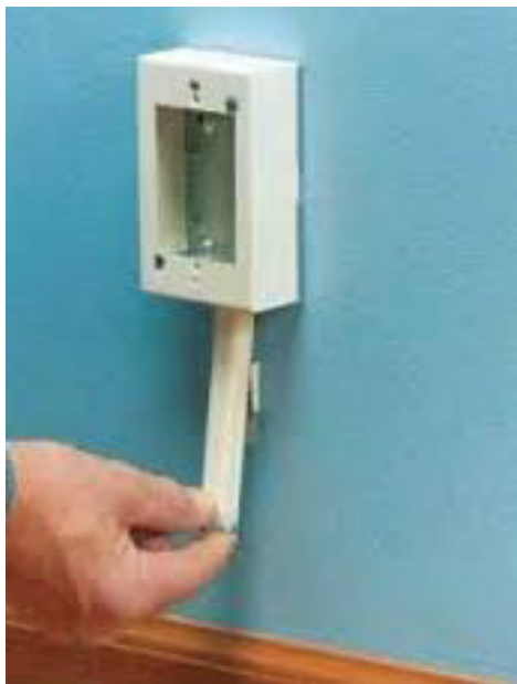
Figura 2.16 Instalación de canaletas, [7].
