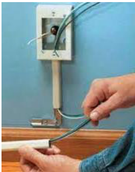
Figura 2.18 Paso de los cables por las canaletas, [7].
