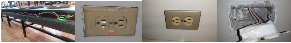
Figura 3.35 Circuito de mesas de trabajo tomas rotas y toma 1 del laboratorio de TICS 22A.
