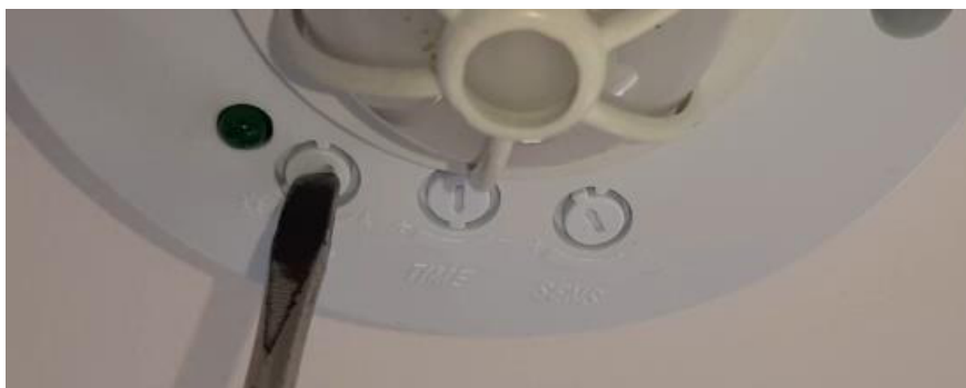
Figura 2.2 Configuración de sensores en modo de encendido para el día.
