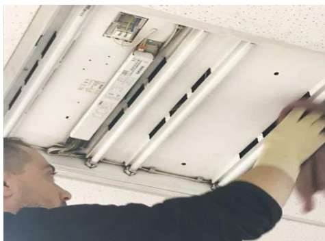
Figura 3.31 Limpieza de luminarias, [27].
