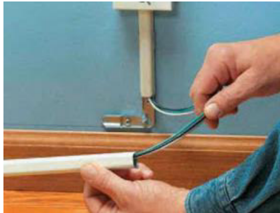
Figura 3.28 Paso de cables por las canaletas, [23].
