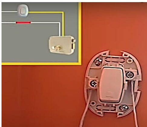
Figura 3.25 Ubicación de pulsadores sistema de acceso.
