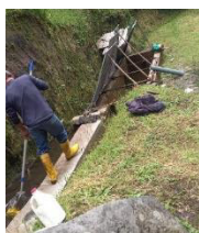
Figura 3.2: Entrada a la captación 1
