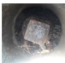
Figura 3.4: Válvula de control
