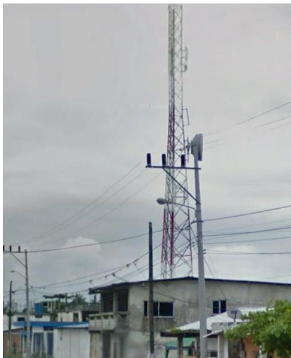
Figura 3.2 Infraestructura nodo CNT.
