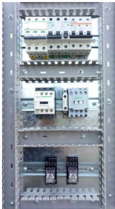
Figura 2.14 Distribución de elementos eléctricos.
