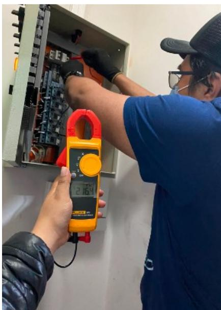
**Figura 2.1.2** Medición de voltaje y amperaje en el tablero general de iluminación.
