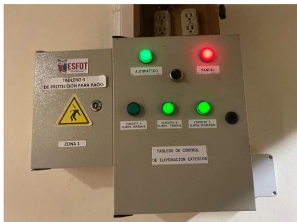
**Figura 2.1.5** Tablero de control de iluminación exterior.
