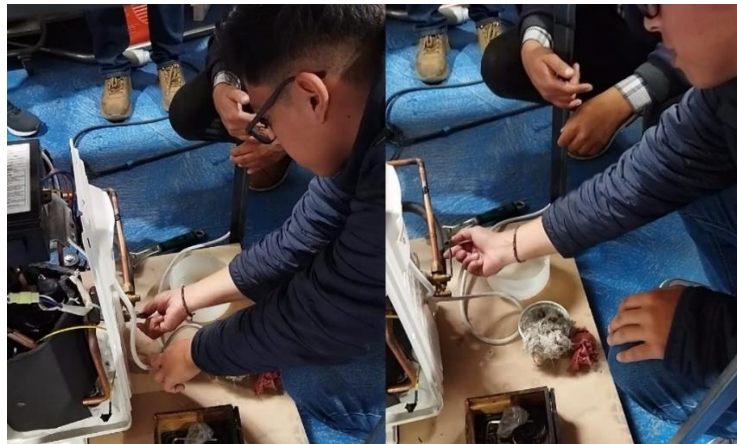
Figura 2.28 Paso de refrigerante
