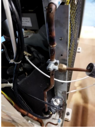
Figura 2.14 Válvula pincha tubo
