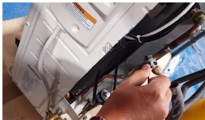
Figura 2.29 Válvula pincha tubo
