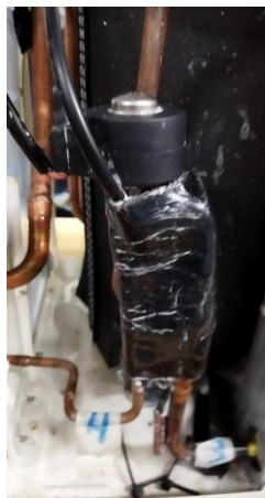
Figura 2.6 Válvula de expansión
