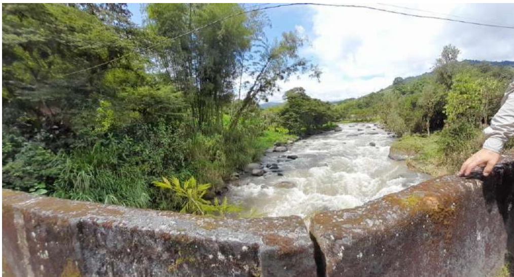
Figura 3.1.1.4. Fotografía panorámica aguas abajo sobre un puente en el río Alambi
