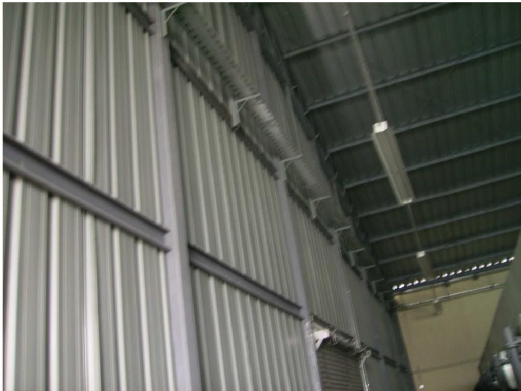
Figura 3.6 Canaletas para montaje de cableado en Texturizado 2
