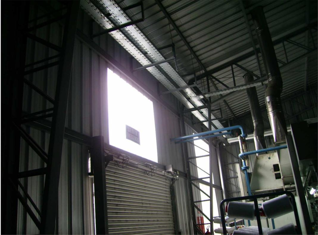
Figura 3.26: Canaleta para transporte de cables de comunicación en planta de Texturizado 2
