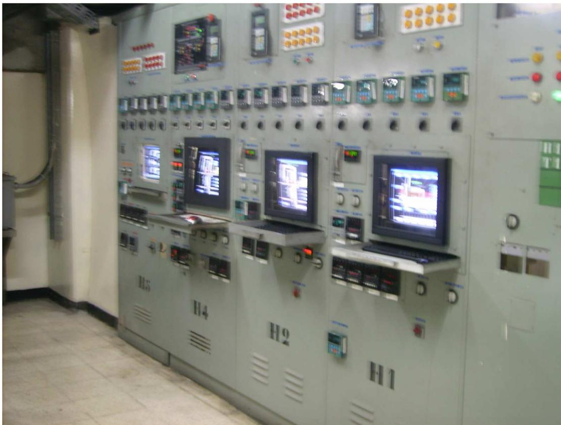
Figura 3.23: Vista frontal de computadores con sistema InTouch
