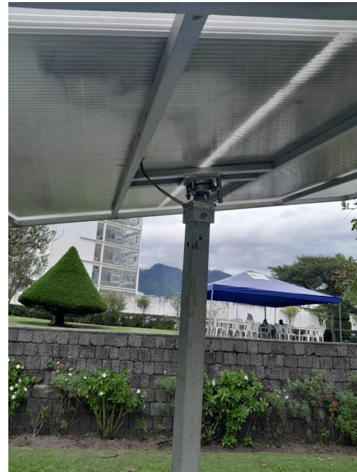
Figura 4 Sistema de generación fotovoltaica instalado en los predios adyacentes al edificio administrativo. Fuente: Elaboración propia.
