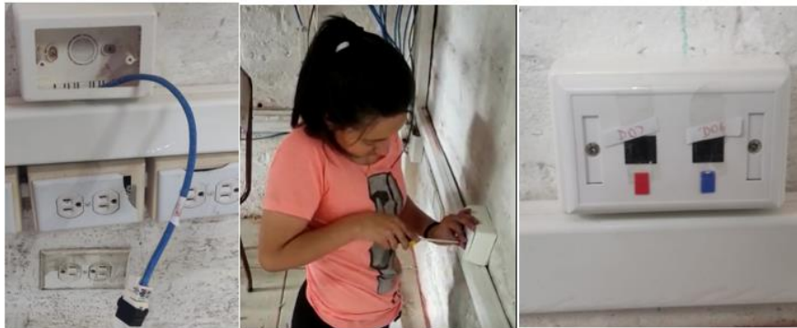
Figura 3.20 Proceso de colocación de faceplate
