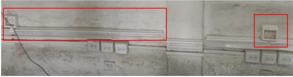
Figura 3.15 Colocación de cajas sobrepuestas y canaleta
