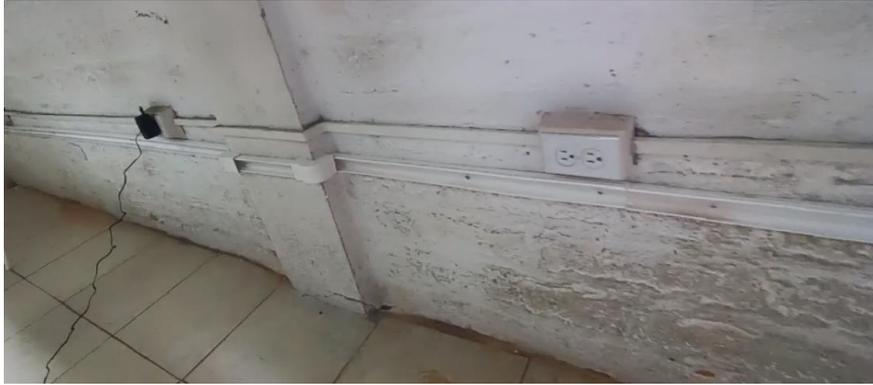
**Figura 3.15** Canalización instalada para los puntos de red
