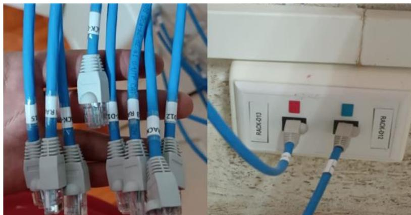
**Figura 3.22** Etiquetado de *patch cords* y puntos de red
