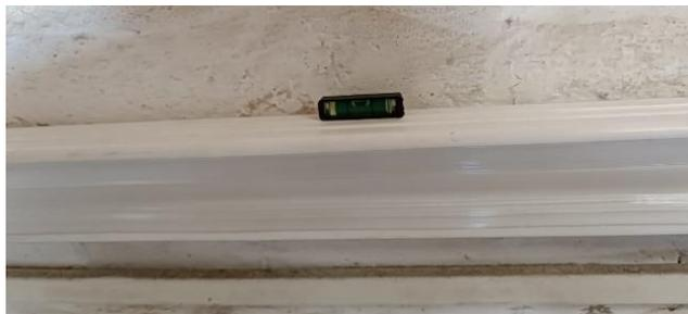
**Figura 3.14** Nivelación del sistema de canalización
