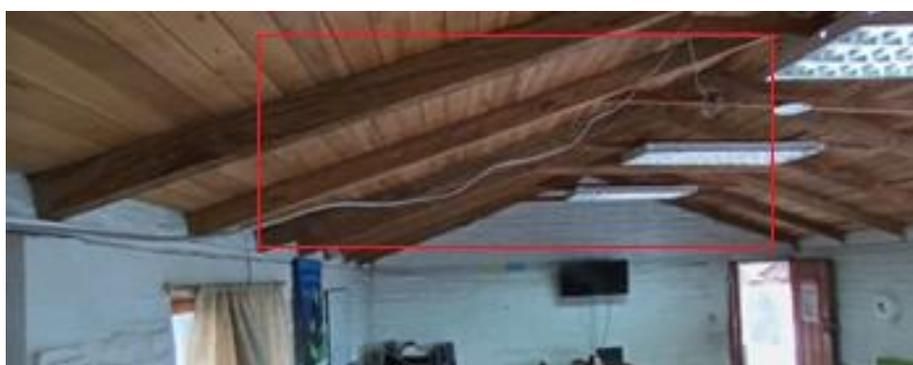
**Figura 3.5** Tendido del antiguo cableado para el equipo del profesor
