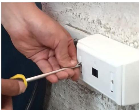
**Figura 3.20** Punto de Red instalado
