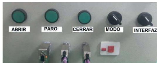
Fig. 17. Interfaz para el control remoto en los actuadores.
