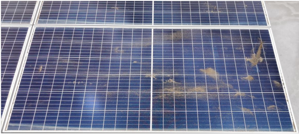
Figura 3.6. Panel con 20 g/m 2 de polvo [Elaboración Propia].
