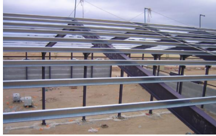
Figura 1. 5 Correas metálicas sobre vigas.
