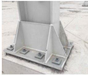
Figura 1. 10 Conexión soldada Fuente: (Andina, 2021)
