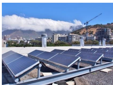
Figura 1. 1 Sistemas de montaje fotovoltaico.
