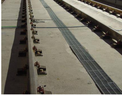
Figura 2.2. Vía en placa con sujeciones DFF (Ayoub, 2014).
