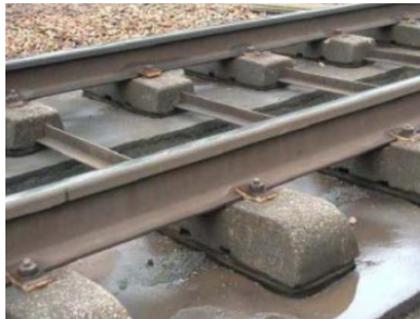
Figura 2.4. Vía Bloque con riostra (Ayoub, 2014).
