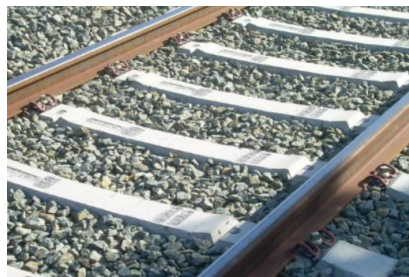
Figura 2.1. Vía convencional con balasto (Ayoub, 2014).
