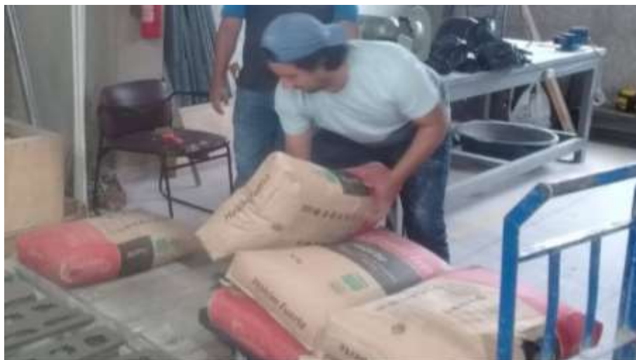
Figura 15. Ubicación de cemento Fuente: elaboración propia
