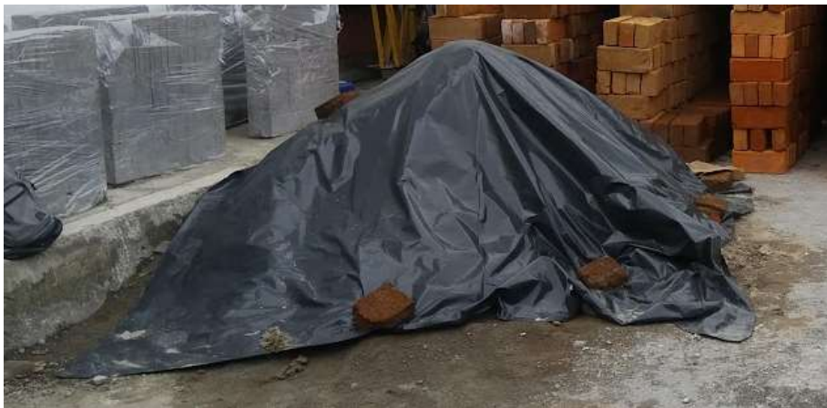
Figura 14. Ubicación de lotes de ladrillo Fuente: elaboración propia
