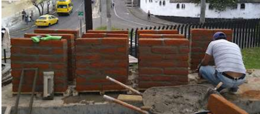
Figura 22. Construcción de muretes 70x70cm
