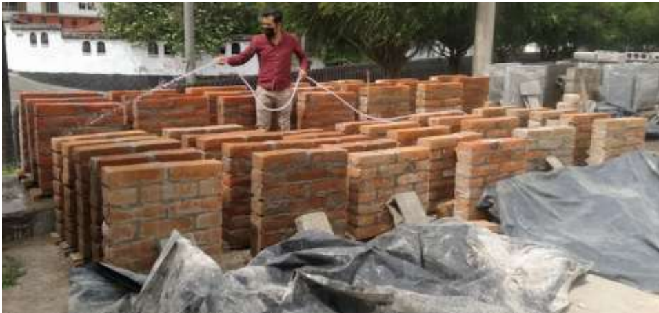
Figura 24. Curado de muretes
