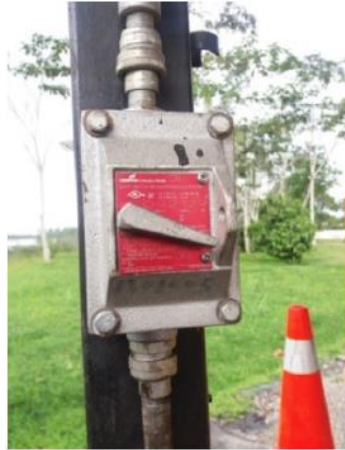
Figura 19. Switch de las lámparas (Escuela de operaciones SERTECPET, 2011).
