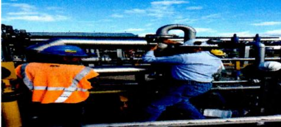
Figura 2.9. Montaje de los equipos en la tubería
