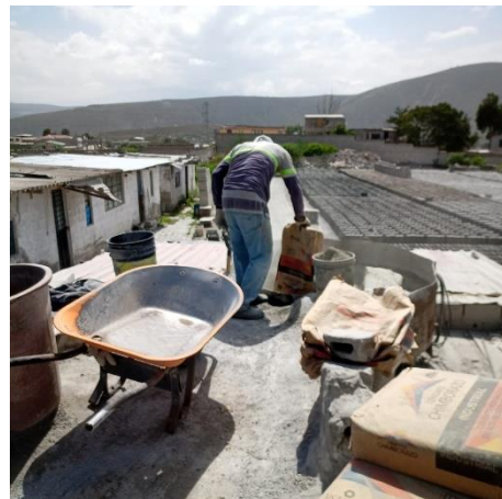
Vertido del cemento
