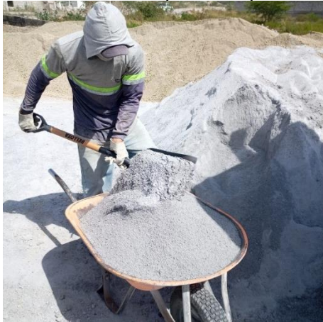
Dosificación del polvo de piedra
