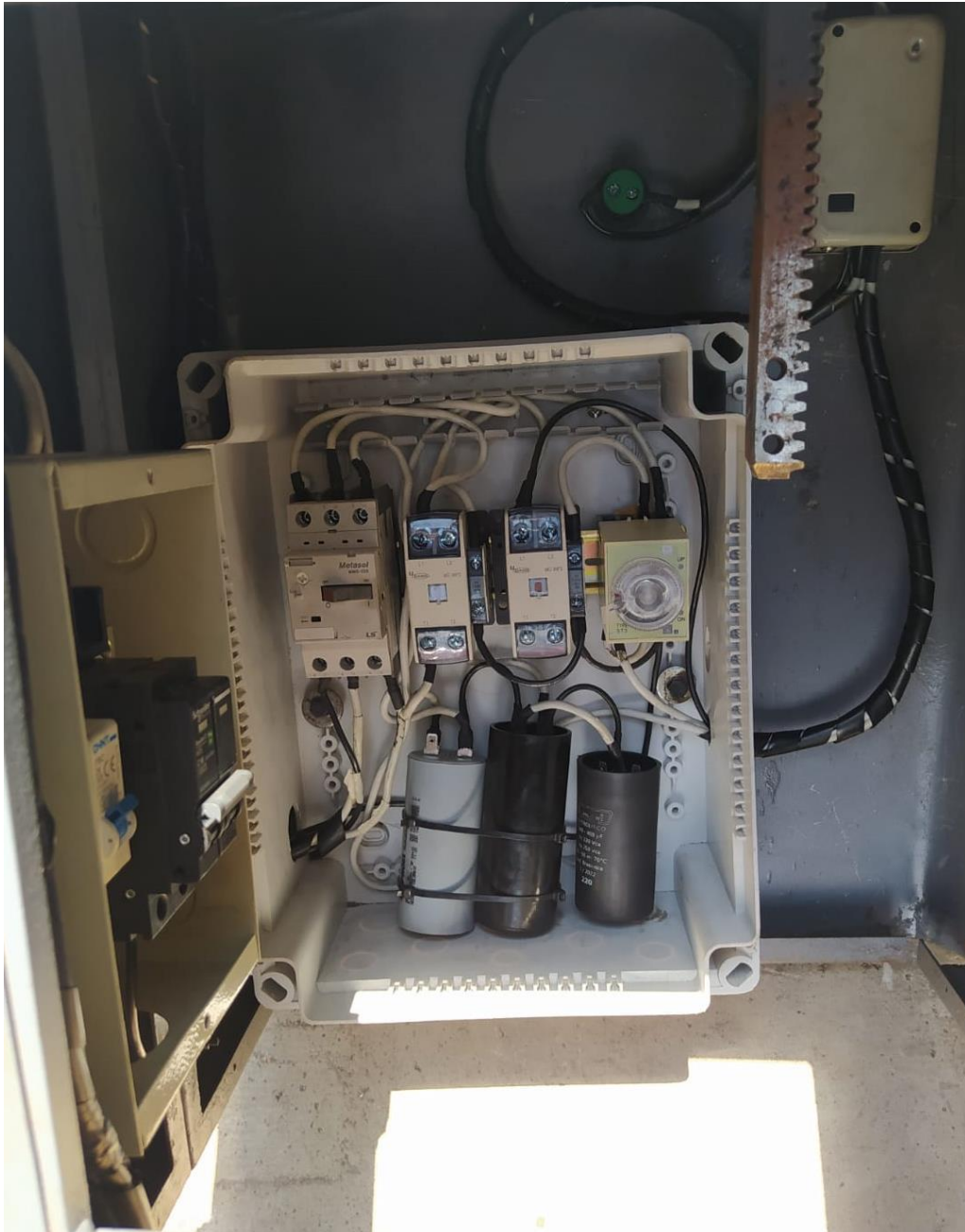
Figura 3.1 Conexiones eléctricas para arranque de motor.
