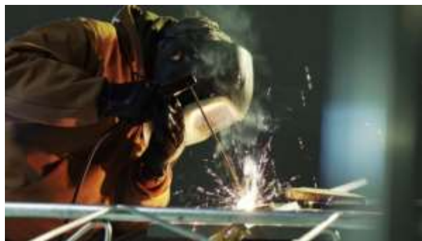
Figura X.III. Proceso de soldadura SMAW [56].
