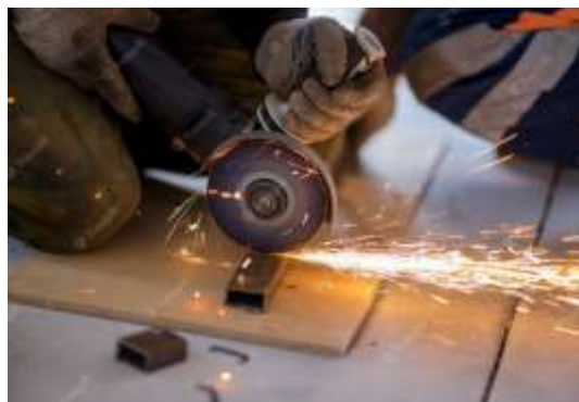
Figura X.I. Corte de tubo metálico de perfil rectangular con amoladora angular [54].
