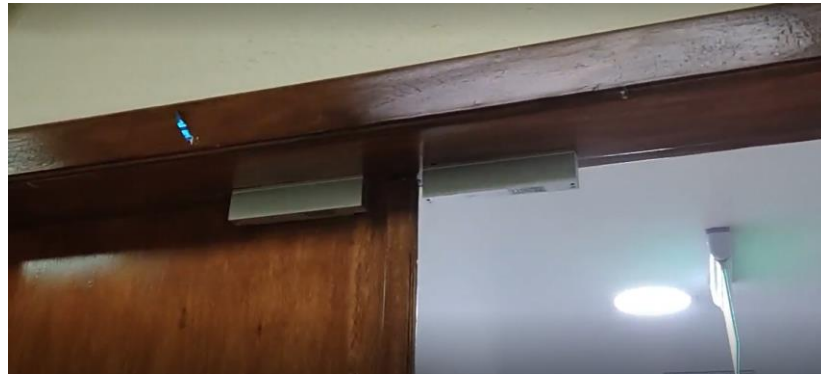
Figura 20 - Cerraduras magnéticas del sistema de control de acceso magnético Fuente: FIS
