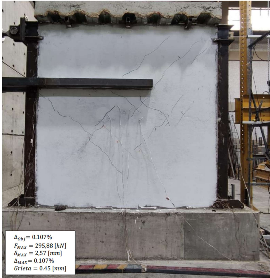
Figura 3.6. Prototipo I con daño previo, reforzado mediante enchape, ensayado a carga lateral en etapa “Daño leve”. [22]
