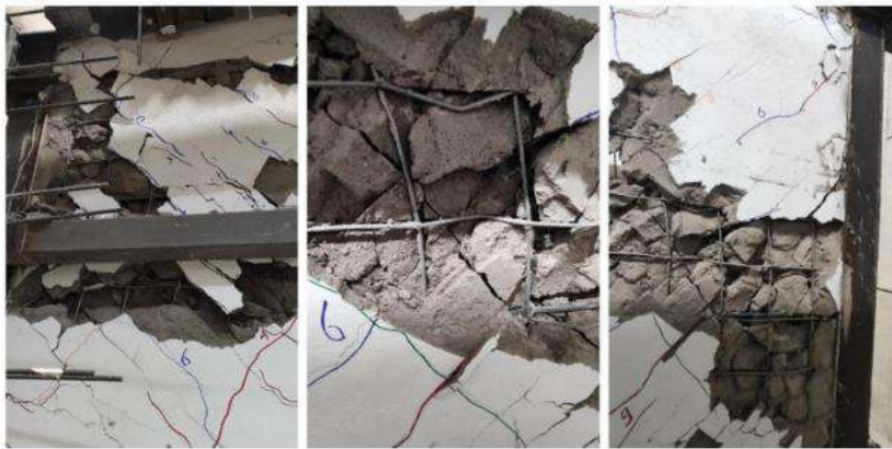
Figura 3.14. Daño Completo de Pórtico Enchapado sin Daño en la Mampostería del Prototipo de Ensayo 1 [34].
