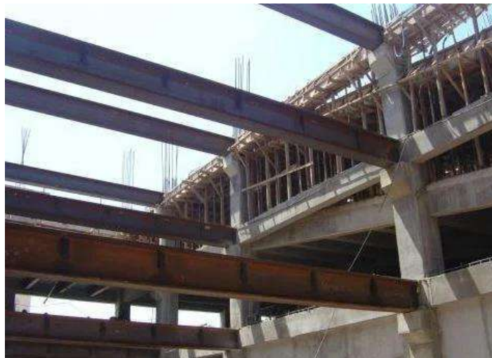
Figura 1.13. Sistema Estructural Mixto Hormigón-Acero [26].
