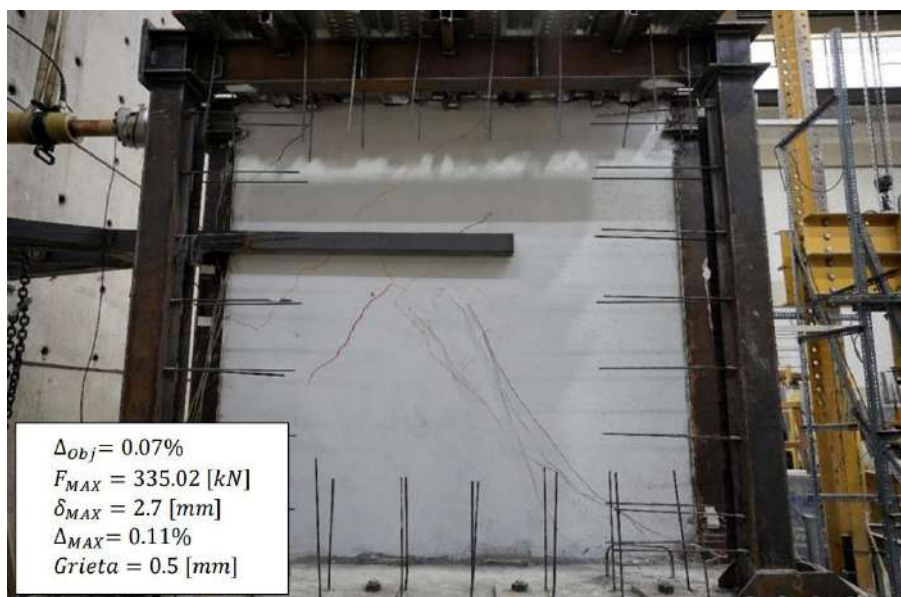
Figura 3.9. Daño Leve de Pórtico Enchapado sin Daño en la Mampostería del Prototipo de Ensayo 1 [34].
