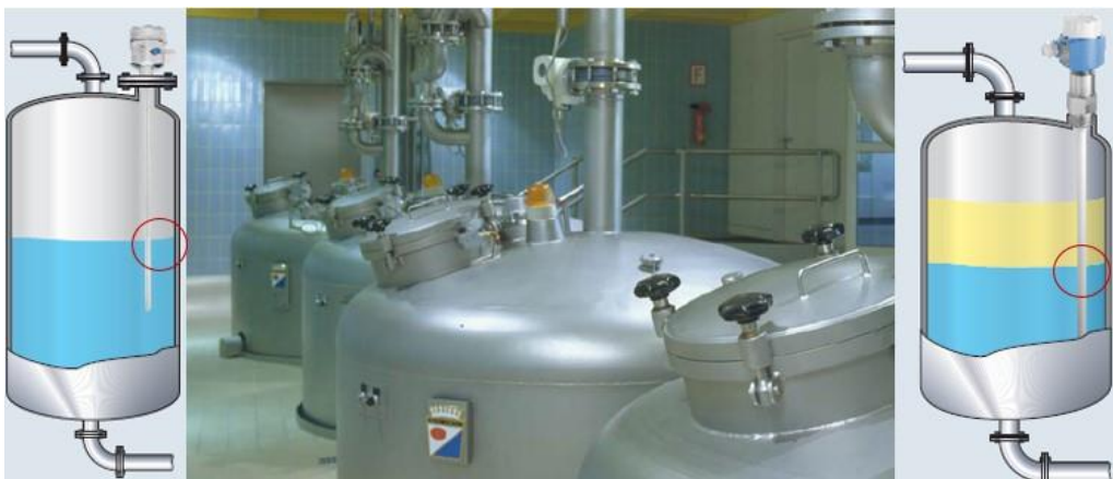
Figura 1.5. Sensor de Nivel Capacitivo [7].
