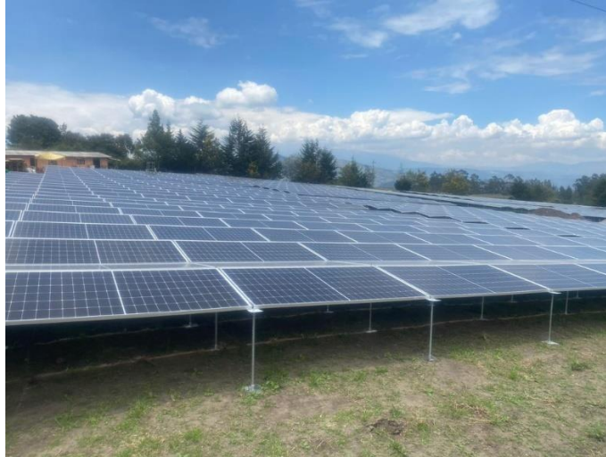
Figura 1.7. Arreglo de módulos fotovoltaicos monocristalinos
