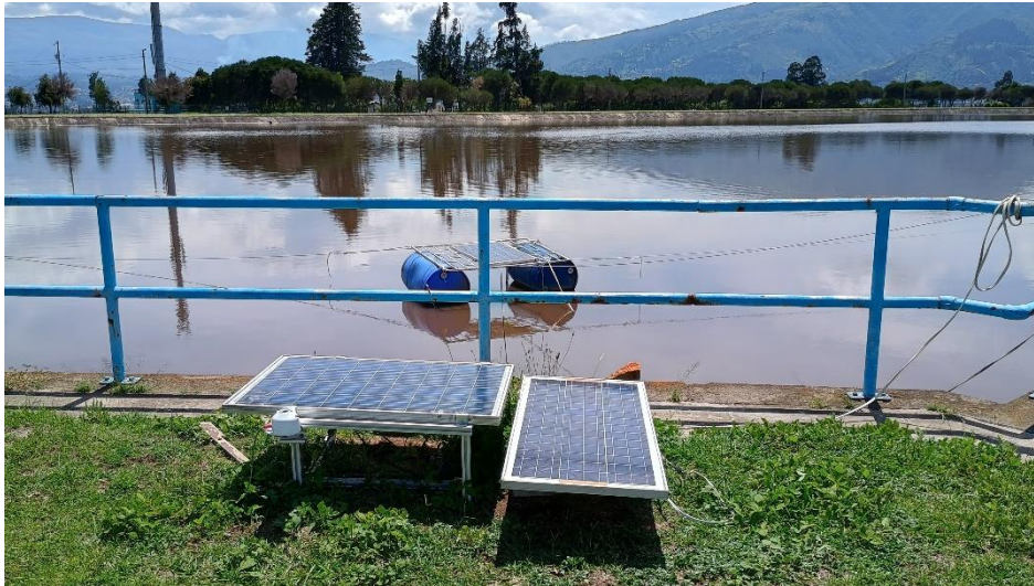
Figura 2.6 Sistema instalado en el reservorio de Cumbayá.
