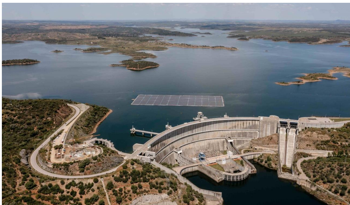
Figura 1.6 Planta solar flotante en el embalse de Alqueva [45].
