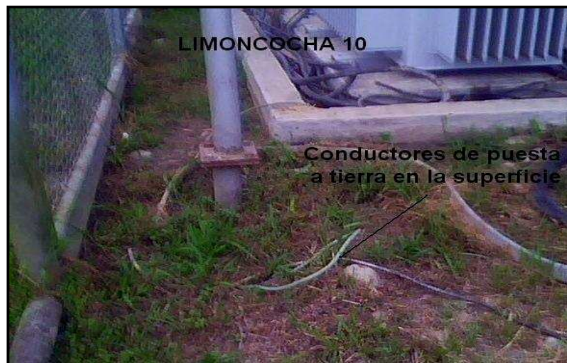
Figura 6.4 Limoncocha 3, conductor de puesta a tierra no enterrado.
