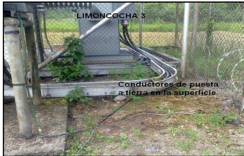
Figura 6.4 Limoncocha 3, conductor de puesta a tierra no enterrado.
