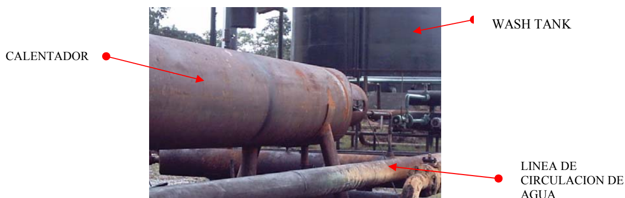
Figura N° 3.3. Distancia desde calentador al Tanque de Lavado
