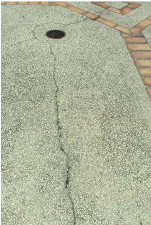
Figura 4.14. Fisuras en la loza de techo.
