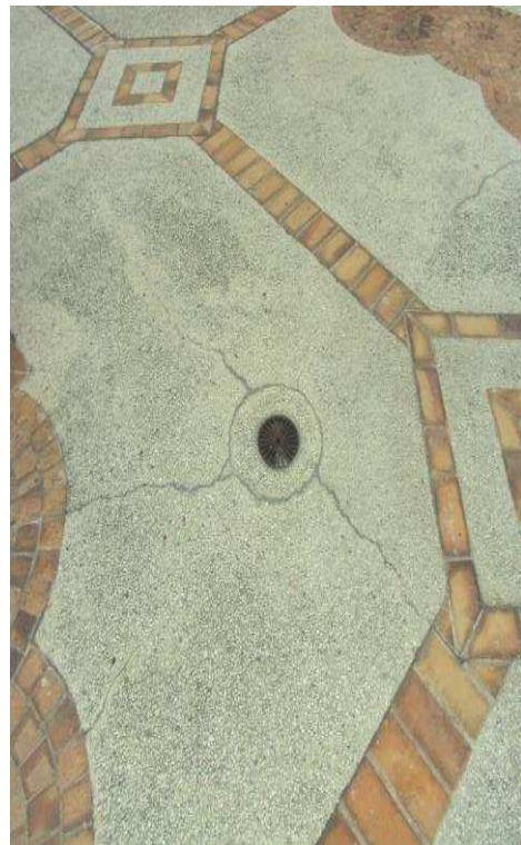
Figura 4.14. Fisuras en la loza de techo.
