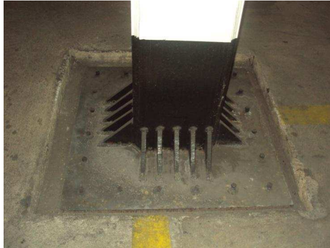
Figura 4.3. Placa de unión columna-cimentación
