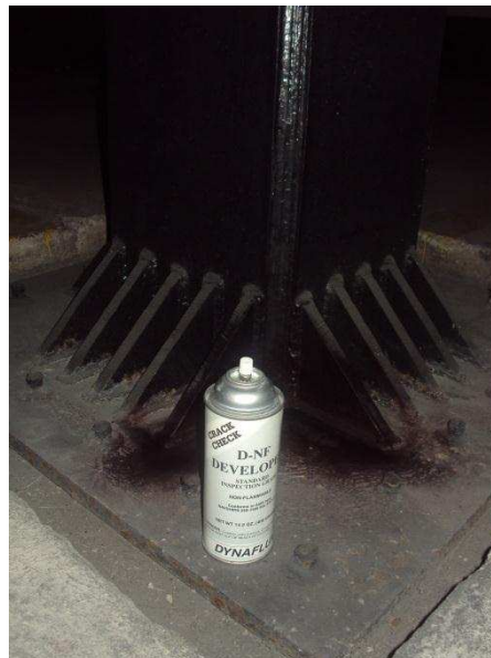
Figura 4.58. Aplicación del revelador.
