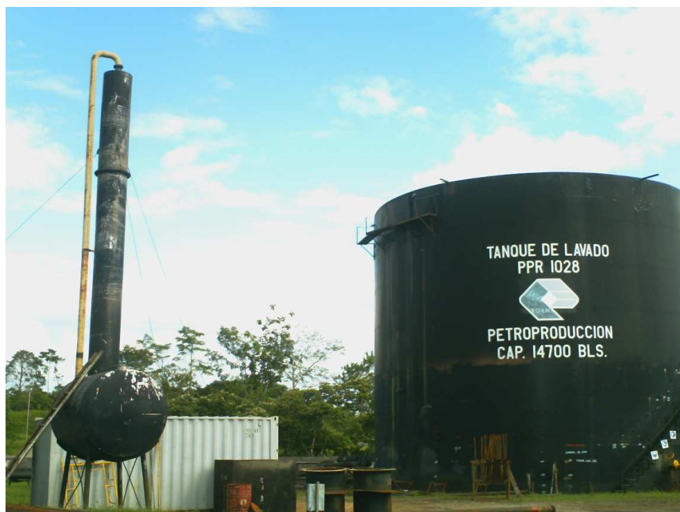
FOTO A 3.2.2 TANQUE DE LAVADO Y BOTA DE GAS ESTACIÓN LAGO CENTRAL
