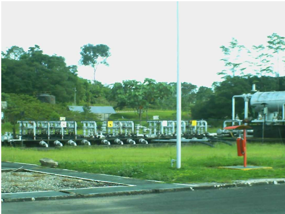
FOTO A 3.2.4 MULTIPLE (MANIFOLD) ESTACIÓN LAGO CENTRAL
