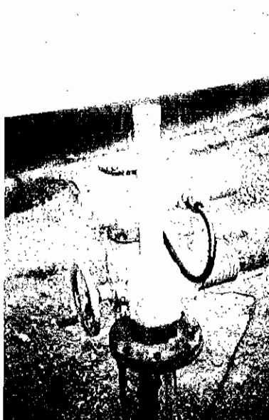
Fotografía 5.12 Cable que ingresa a válvulas
