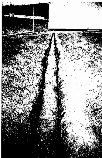
Fotografía 5.5 Vista de la zanja sin el cable
