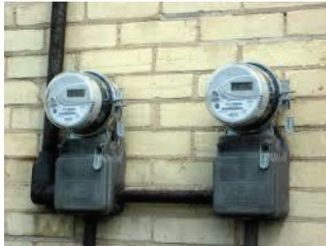
Figura 39: Fotografía de Medidores Para Medición Bidireccional
