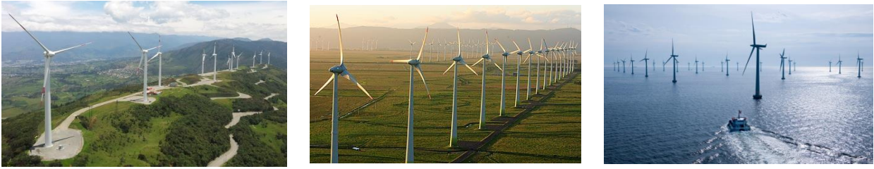
Figura 2.13 Parques eólicos terrestres y marinos
