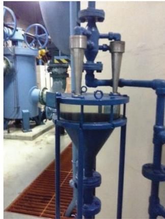
**Figura 1.19.** Filtro Tipo Vórtex
