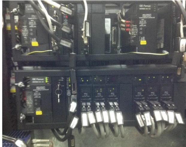
**Figura 1.44.** Unidad de Adquisición de Datos - Casa de máquinas
