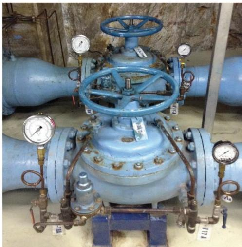
**Figura 1.10.** Válvulas Motorizadas 20 WC – A/B
