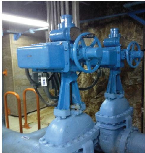
**Figura 1.13.** Válvulas Motorizadas 20 EW A/B
