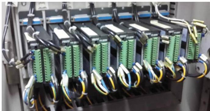
**Figura 1.37.** Presys - TY 2090 Instalados
