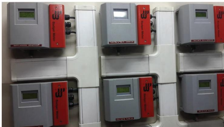
**Figura 1.32.** Acondicionadores de Flujiómetros Electromagnéticos
