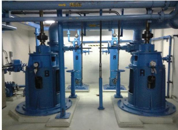
**Figura 1.12.** Bombas de 150 kW del Sistema de Emergencia
