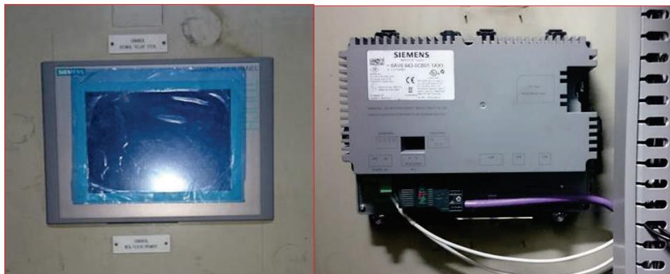
**Figura 2.64.** Panel táctil montado en el tablero
