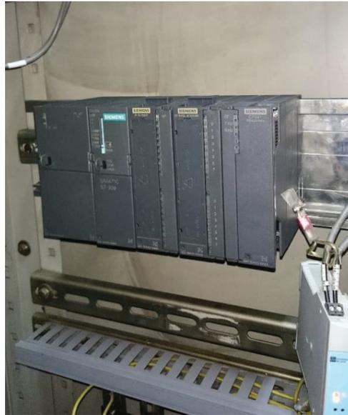
**Figura 2.60.** PLC fijado al tablero
