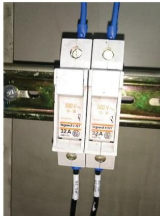
**Figura 2.66.** Fusibles instalados
