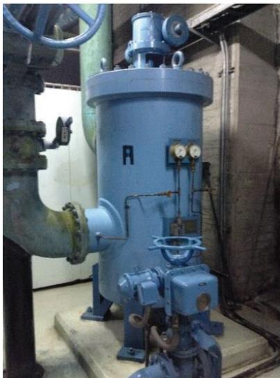
**Figura 1.11.** Filtro del Tren A de Distribución del Sistema Principal de Enfriamiento
