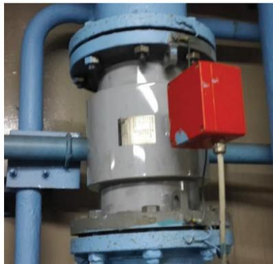
**Figura 1.31.** Flujómetro Electromagnético Instalado
