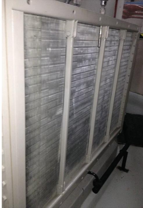
**Figura 1.22.** Intercambiador de Calor Aire-Agua del Generador
