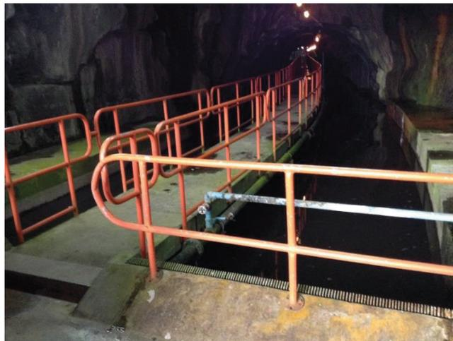
**Figura 1.6.** Desarenador del Sistema Principal de Agua de Enfriamiento
