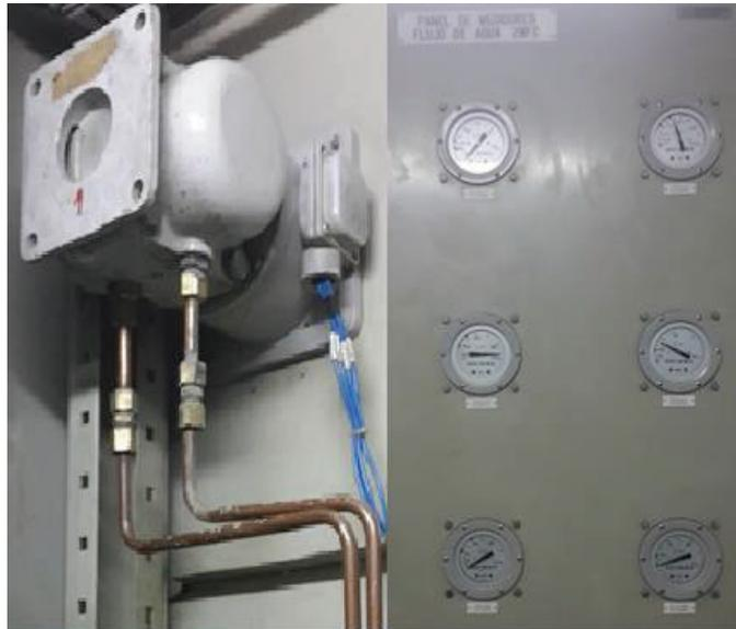
**Figura 1.29.** Indicadores de los Sensores de Placa Orificio
