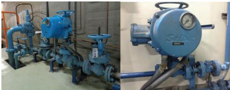
**Figura 1.20.** Válvulas Motorizadas 20 WC y 20 ESW-1
