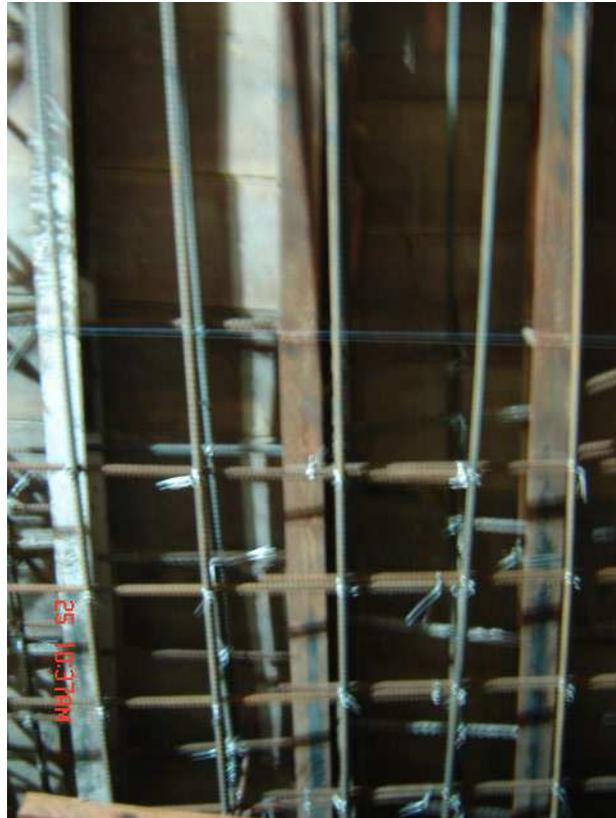
Figura N° 81.- Armado estructural entre cerchas metálicas y celosía.
