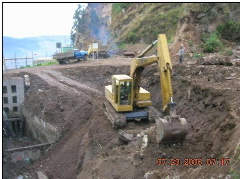
Figura N° 18.- Vista frontal aguas abajo excavación a colector a cielo abierto en la abscisa 0+100.00
