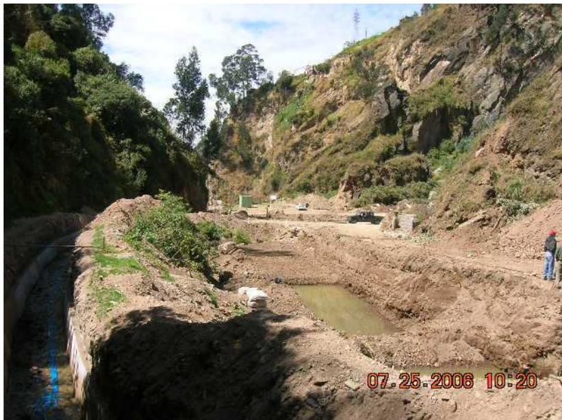
**Figura N° 9.- Imagen del colector después de haber realizado las primeras excavaciones**
