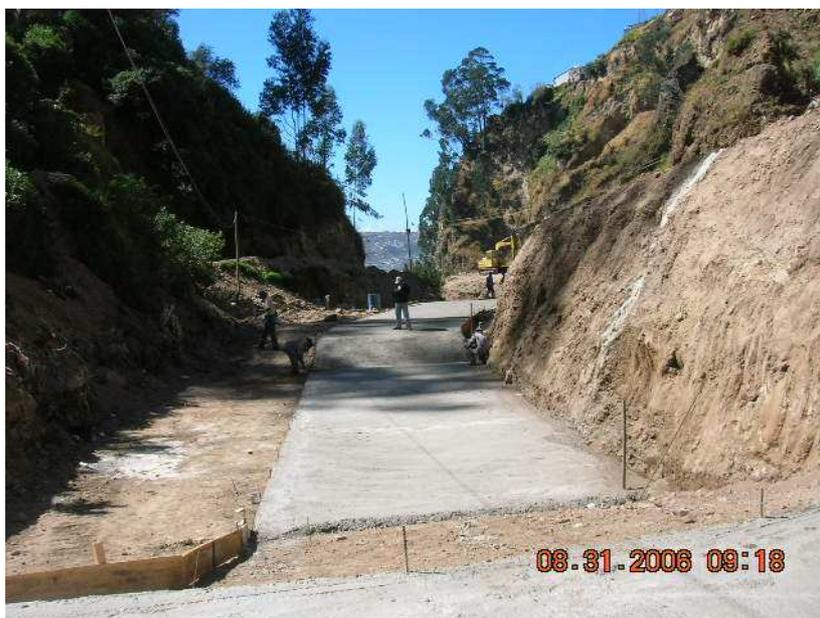
**Figura N° 37 .-Colocación de encofrado lateral y replantillo de estructuras**
