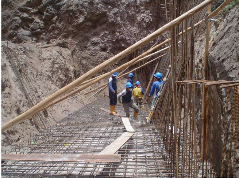
**Figura N° 28.- Armado de zapata en sentido norte sur de la zapata del dique**
