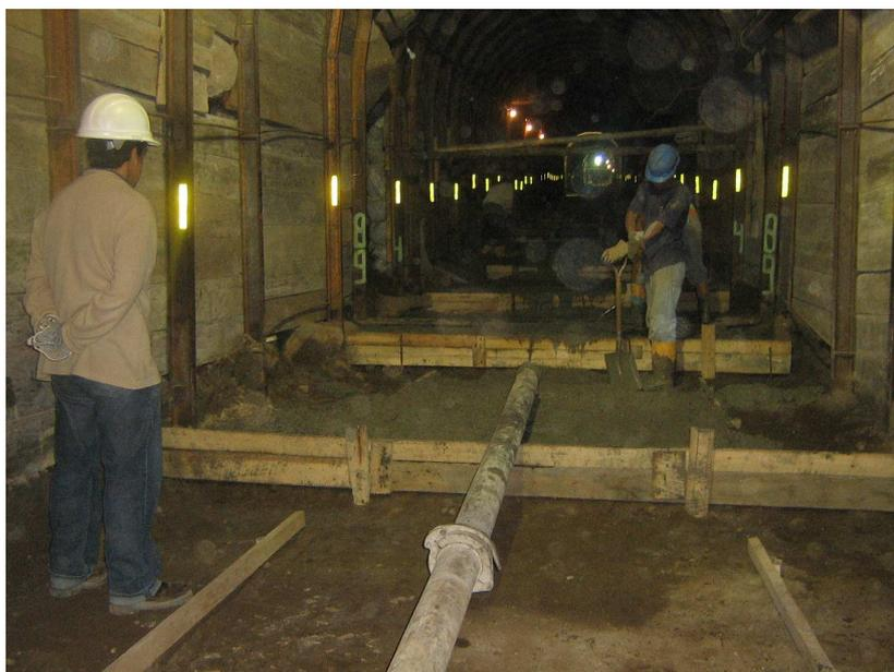
**Figura N° 86.- Hormigonado de replantillo en túnel.**
