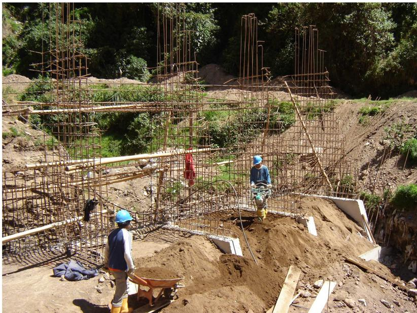
**Figura N° 31.- Relleno y compactación entre contrafuertes del dique.**
