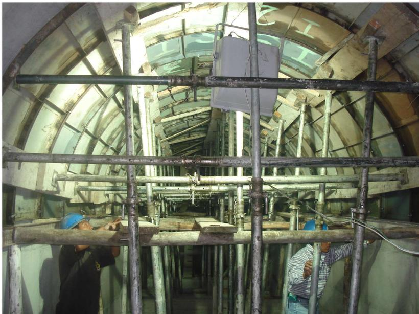
Figura N° 84.- Encofrado y apuntalamiento de bóveda de túnel.
