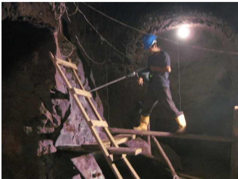
**Figura N° 73.- Rotura de bloques de roca con rompedores eléctricos**
