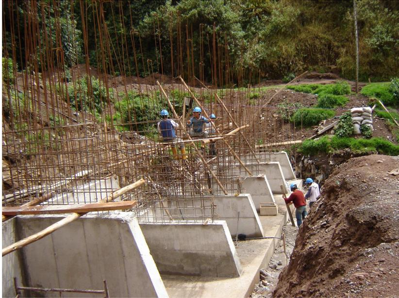
**Figura N° 30.- Continuación de la armado de la segunda sección de pantalla y contrafuertes**
