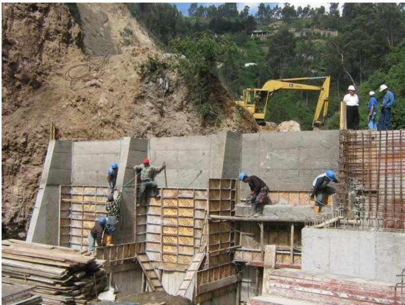
**Figura N° 36.- Desencofrado de pantalla del Dique**
