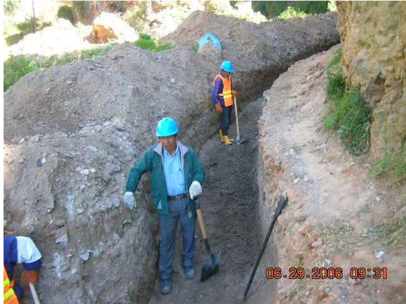
Figura N° 11.- Canal excavado margen izquierda del dique aguas abajo, sección trapezoidal para ingreso al antiguo Colector 24 de mayo.
