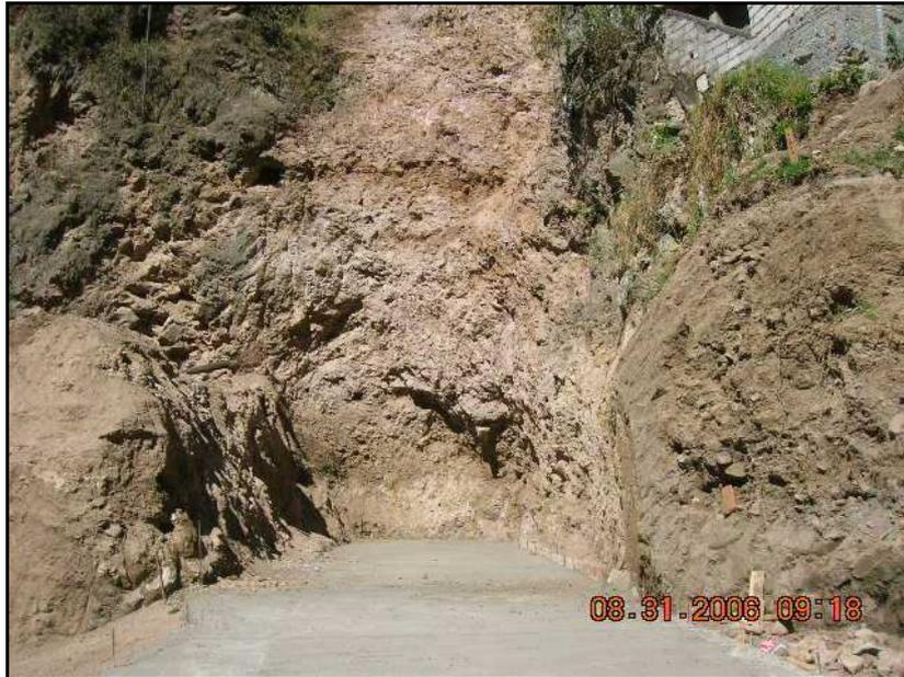
**Figura N° 27.- Replanteo de hormigón f'c: 140 kg/cm<sup>2</sup> en dique**
