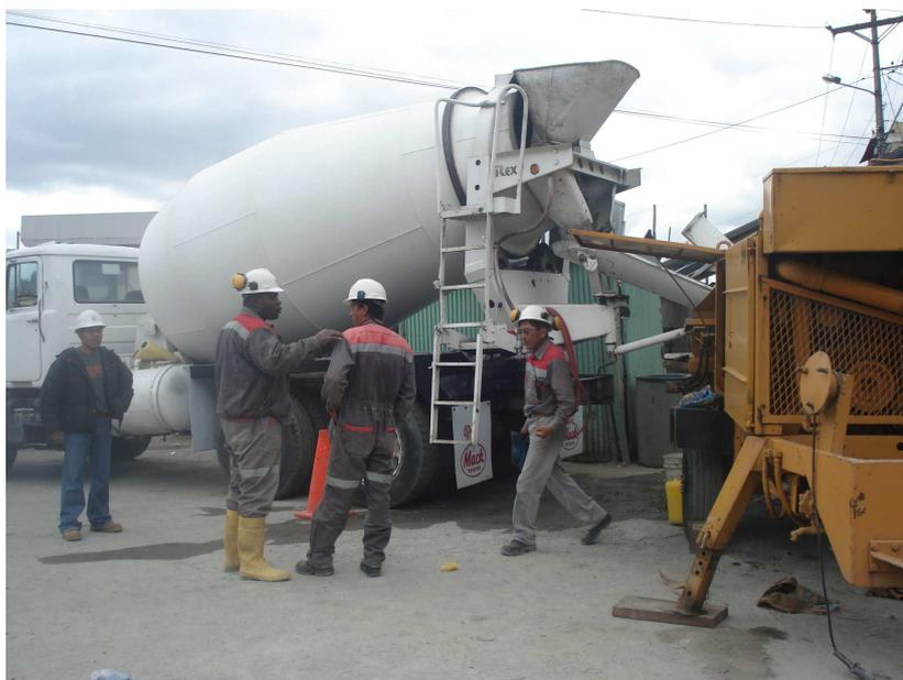
**Figura N° 85.- Mixer de hormigón premezclado y bomba de hormigón**
