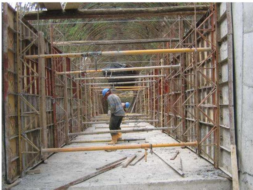
**Figura N° 43.- Apuntalamiento de paredes con gatas metálicas**
