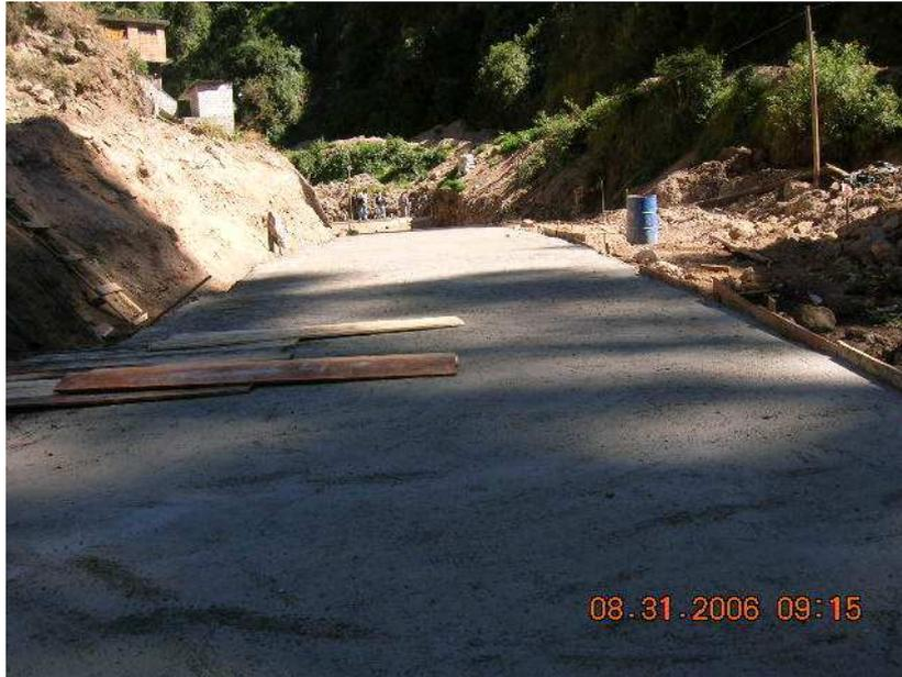
**Figura N° 38.- Replantillo segundo tramo de colector**
