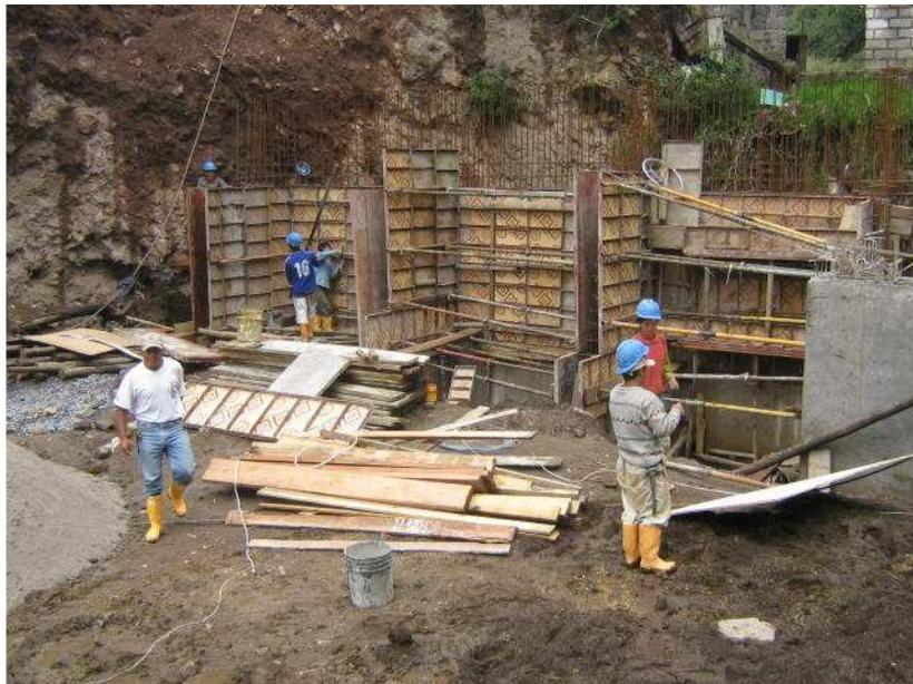
**Figura N° 34.- Encofrado de pantalla del dique margen izquierda aguas arriba**
