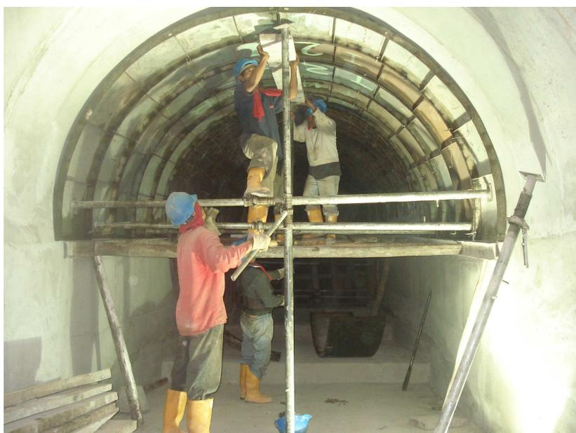
**Figura N° 89.- sección completa de hormigón en túnel**
