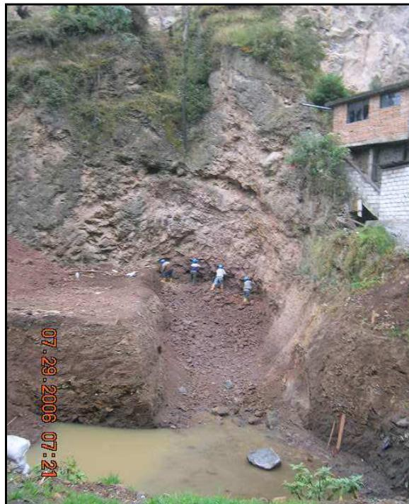
**Figura N° 17.- Excavación margen derecha aguas abajo en roca utilizando martillos neumáticos**
