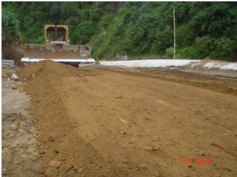
**Figura N°.- 48 Relleno lateral de estructura de colector**
