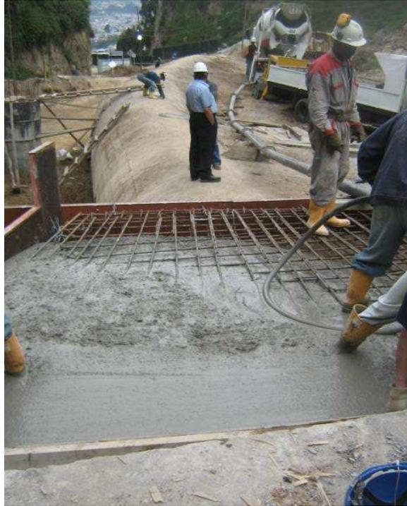
**Figura N° 33.- Hormigonado de losa superior del dique**
