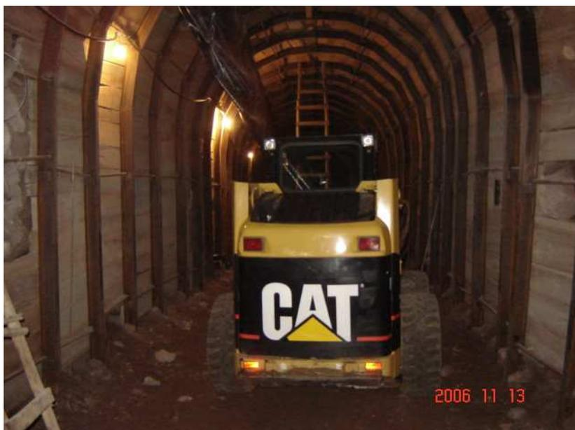
**Figura N° 76.- Mini cargadora realizando rezague horizontal de material al interior del túnel.**
