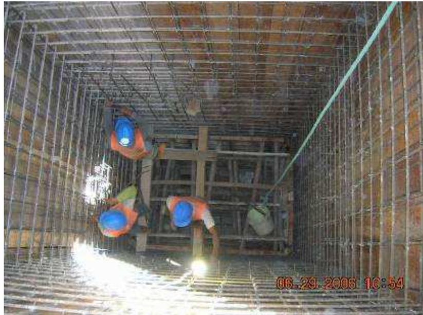
**Figura N° 58.- Armado estructural del pozo de caras internas y externas**
