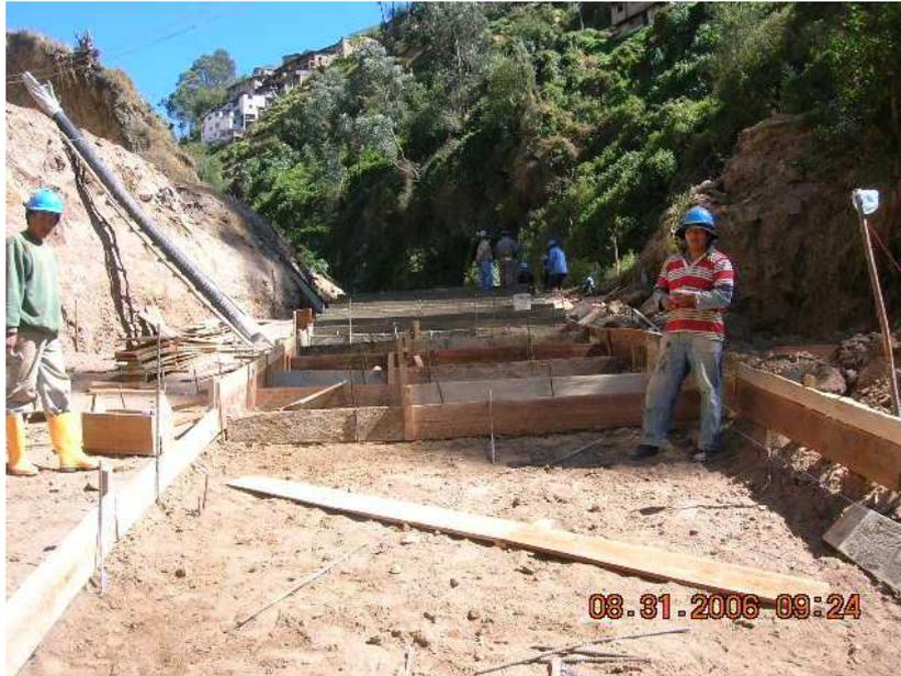
Figura N° 39.- Conformación de gradas de replantillo con encofrado
