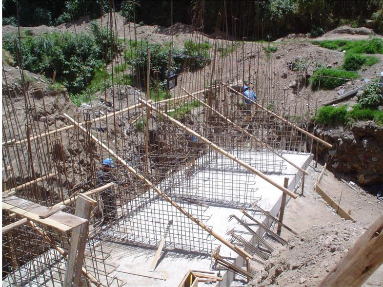
**Figura N° 29.- armado de contrafuertes del dique**
