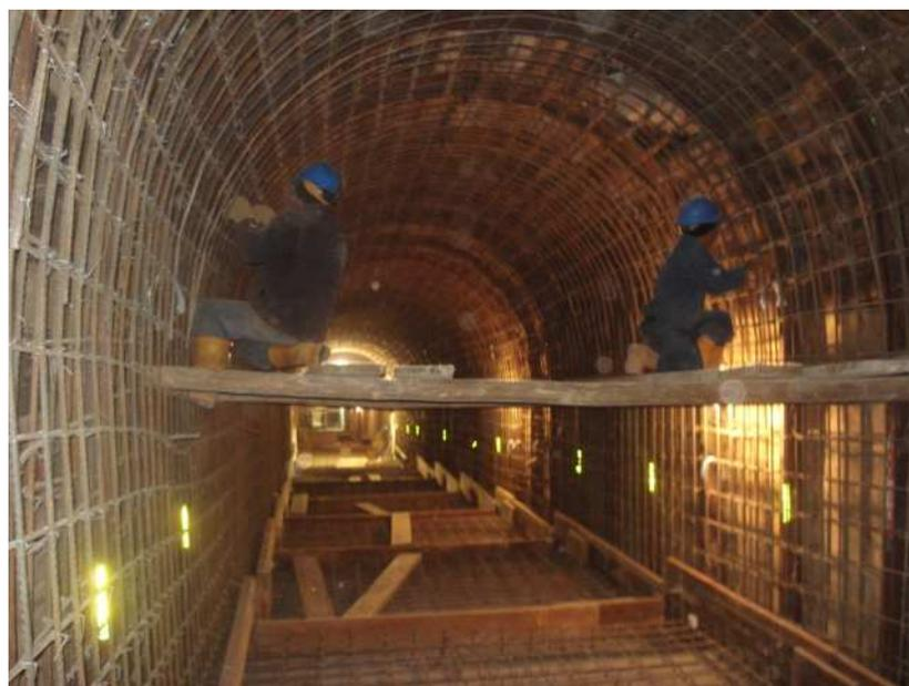
**Figura N° 80.- Armado estructural en toda la sección del túnel.**
