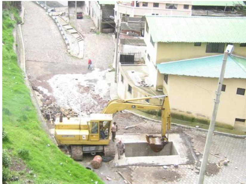
**Figura N° 50.- Excavadora hidráulica, extrayendo el material del pozo PVM3'**
