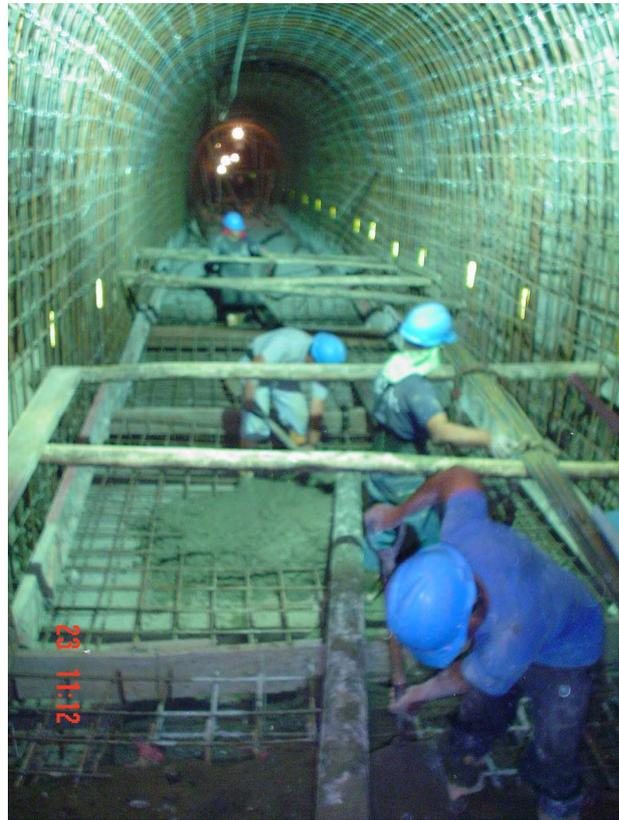
**Figura N° 87.- Hormigonado de solera y guía de pared**
