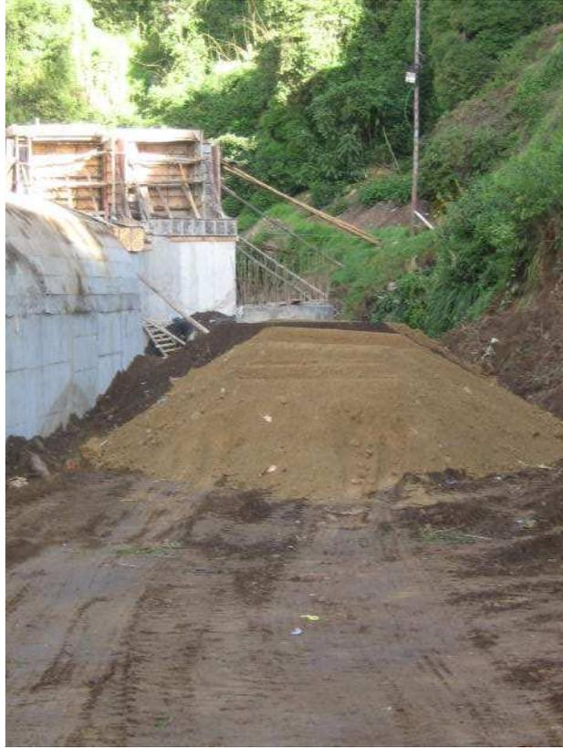
**Figura N°.- 47 Acopio de material para confinamiento de estructura**
