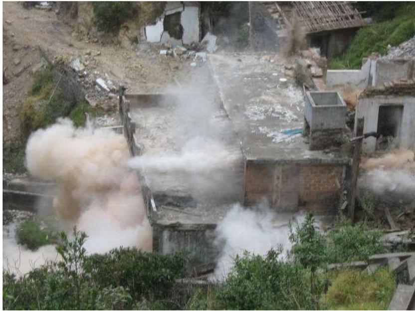
**Figura N° 15.- Casa derrocada con voladuras, ubicada en el sector alto del Dique.**
