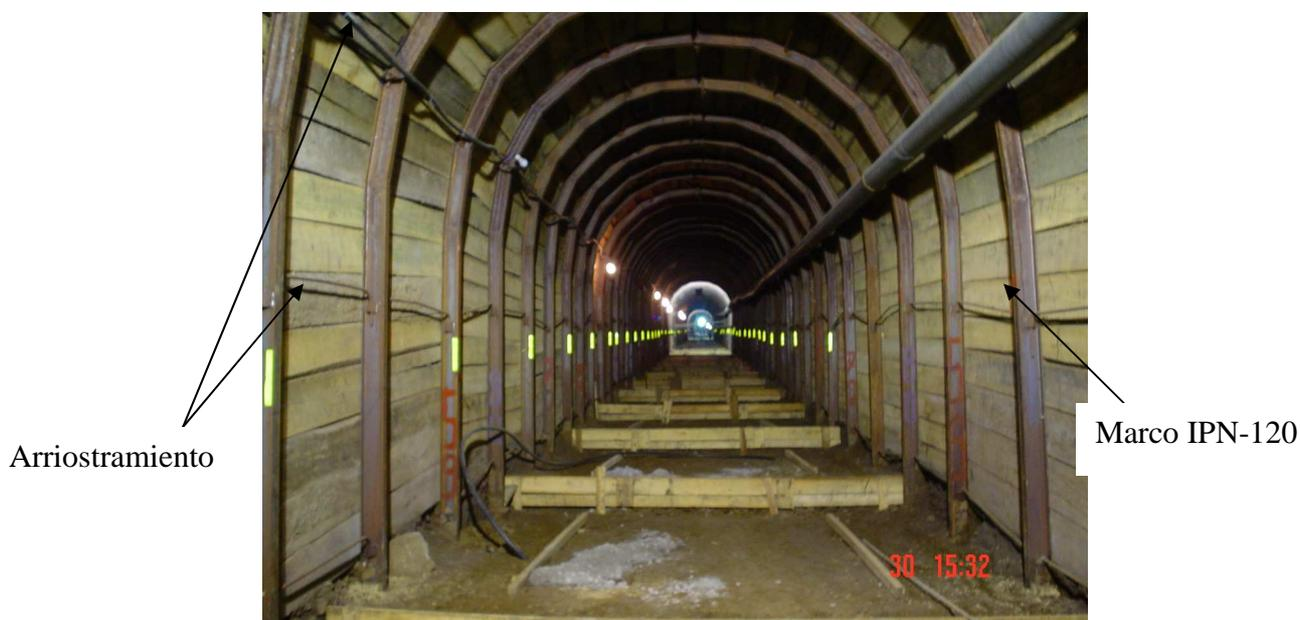
**Figura N° 78.- Sostenimiento con marcos metálicos de perfil IPN-120**
