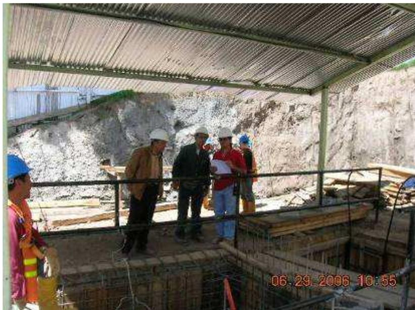
Figura N° 56.- Cubierta sobre PVM4' para proteger a la estructura de épocas invernales.
