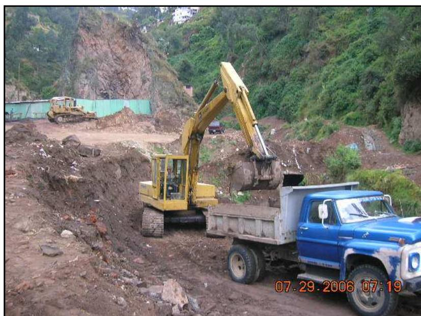
Figura N° 19.- Vista frontal aguas arriba excavación colector a cielo abierto
