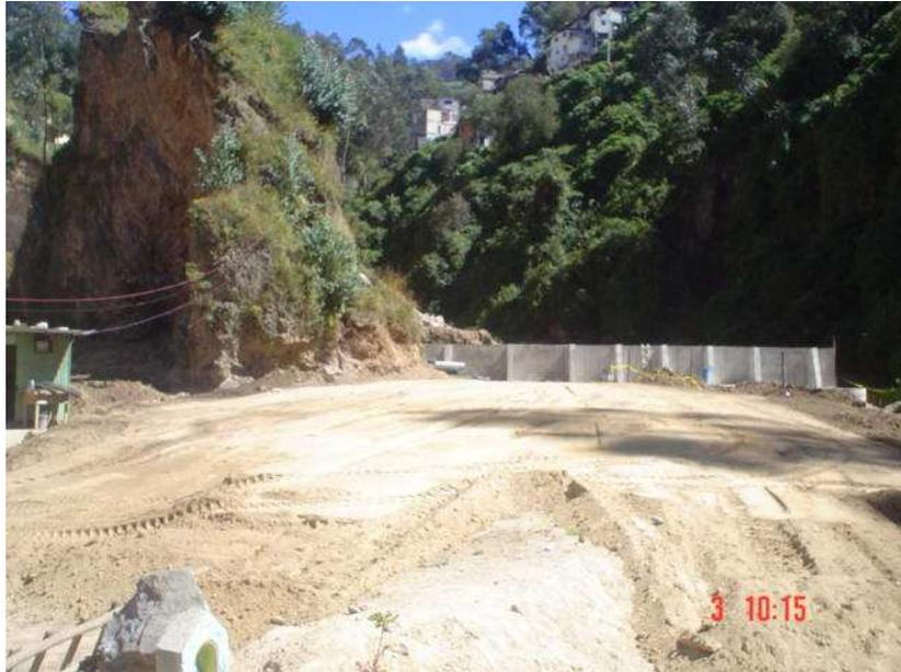
**Figura N° 49.- relleno compactado sobre estructura de colector**
