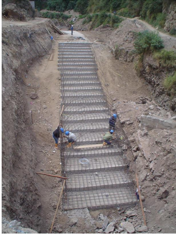
**Figura N° 40.- Armado estructural de solera en colector desde aguas abajo hacia aguas arriba desde la abscisa 0+086.32**
