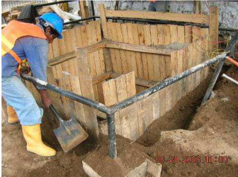
Figura N° 55.- Colocación de barandas o pasamanos de seguridad en pozos
