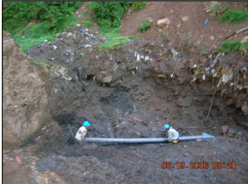
**Figura N° 26.- Tubería drenaje para conducción de aguas de infiltración.**
