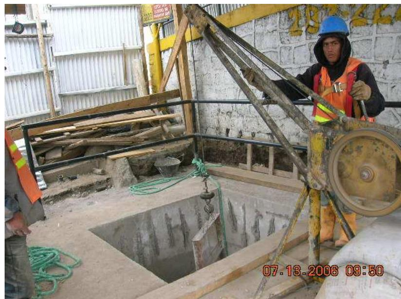
**Figura N° 52.- Rezague vertical de material arenoso en PVM5'**
