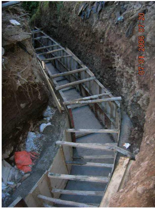
**Figura N° 12.- Encofrado de canal de desvío.**
