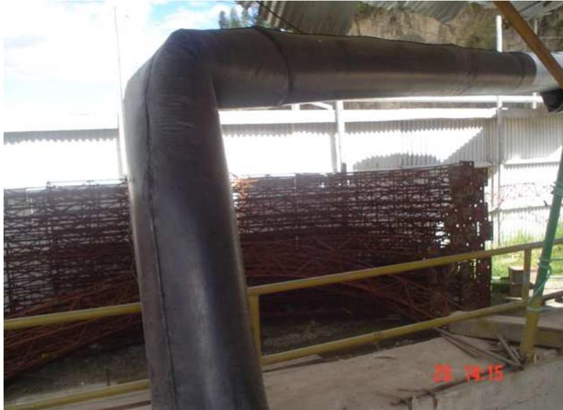
**Figura N° 77.- Manga de ventilación de ingreso al túnel.**
