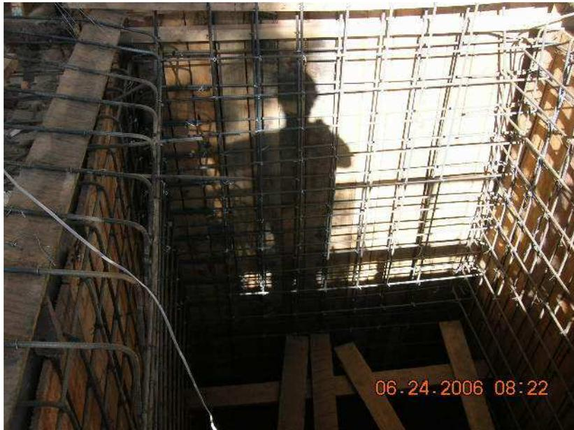
**Figura N° 59.- Encofrado en pozo, completamente libre de residuos de cualquier material**
