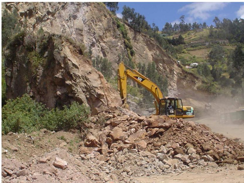
Figura N° 6.- Excavación del diente de roca, para instalar el Campamento del dique
