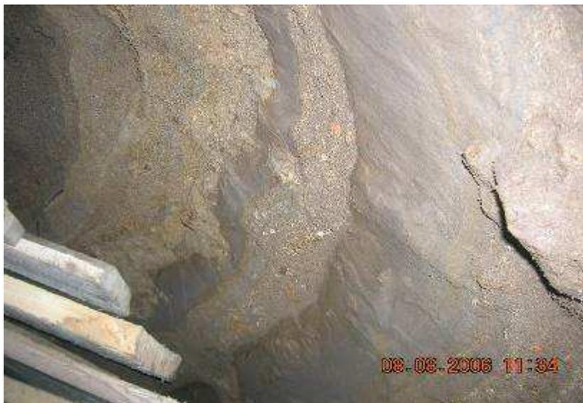
**Figura N° 69.- Chimenea producida en frente de excavación PVM5' hacia el PVM4' aguas arriba**
