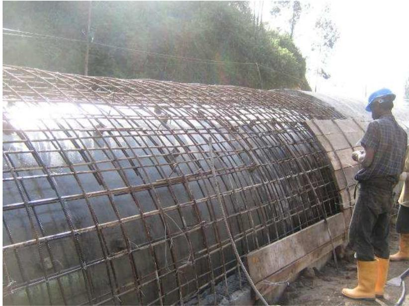
**Figura N° 45.- Encofrado interno y externo de bóveda de colector**
