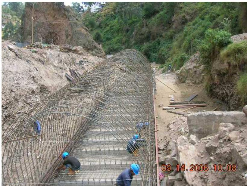
Figura N° 42.- Encofrado de guía de pared de paredes de colector
