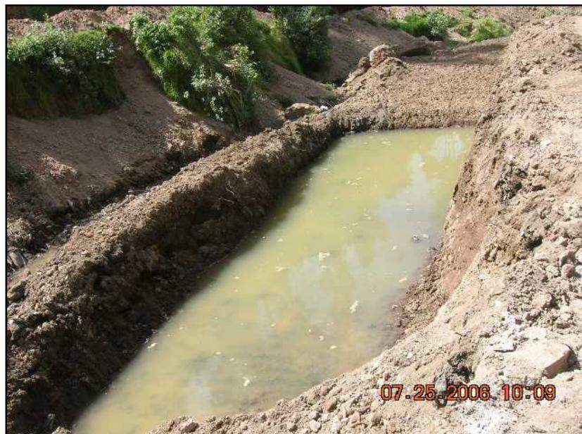
Figura N° 21.- Nivel freático entre abscisas 0+013.00 – 0+033.00 sector colector.
