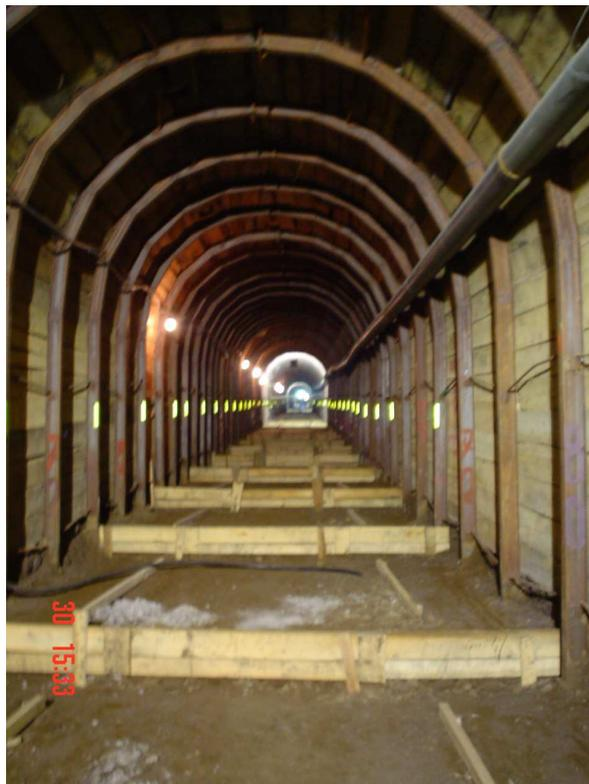
**Figura N° 82.- Vista frontal de encofrado de contrahuella para replantillo**
