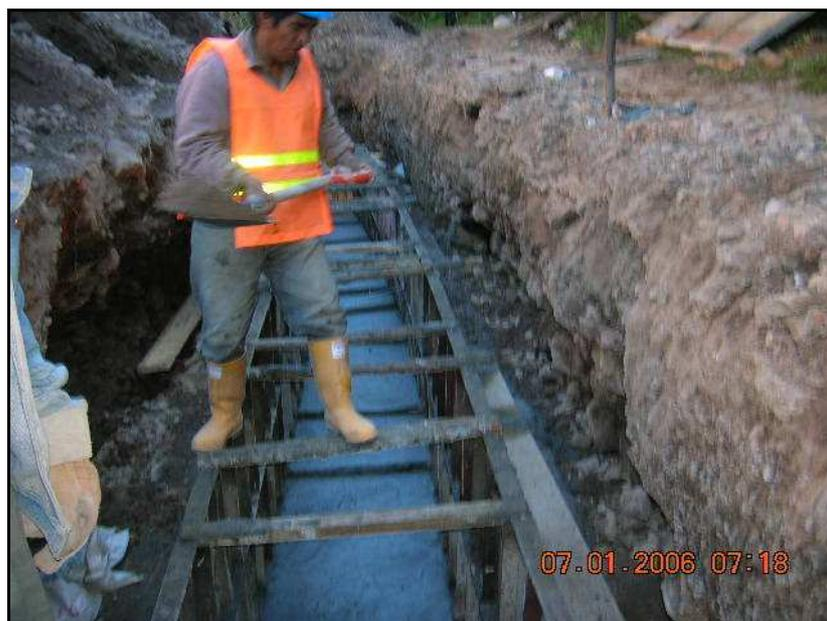
**Figura N° 13.- Hormigonado de canal de desvío**
