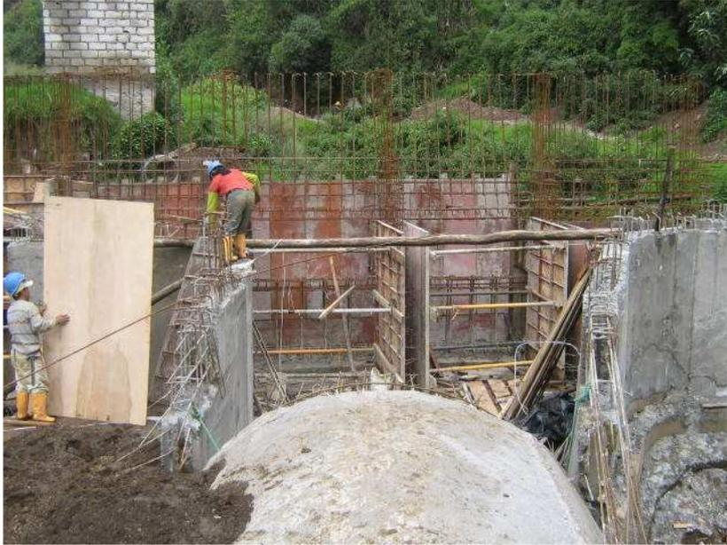
**Figura N° 35.- Encofrado tercer tramo de la pantalla del dique aguas arriba**
