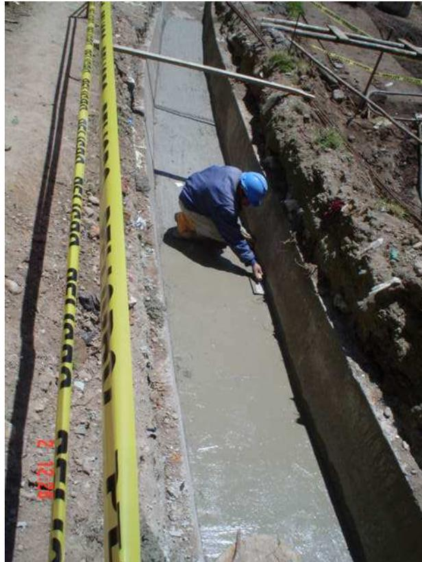
**Figura N° 14.-Recubrimiento con aditivo para impermeabilizar el canal de desvío**
