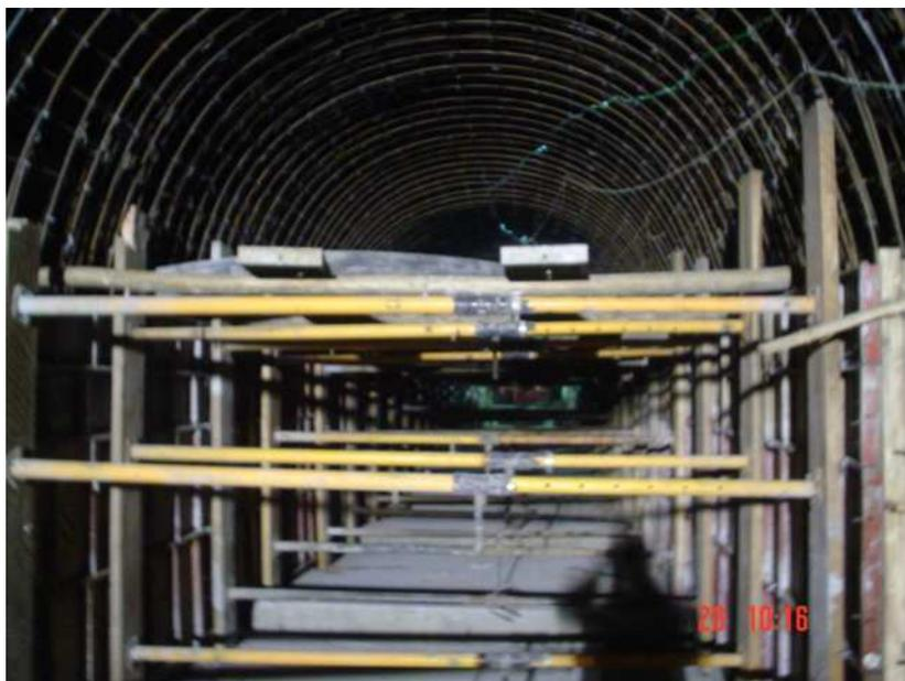
**Figura N° 83.- Encofrado y apuntalamiento de paredes**
