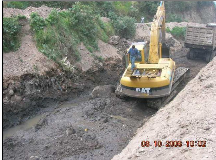
**Figura N° 22.- Excavación en material fangoso y relleno**
