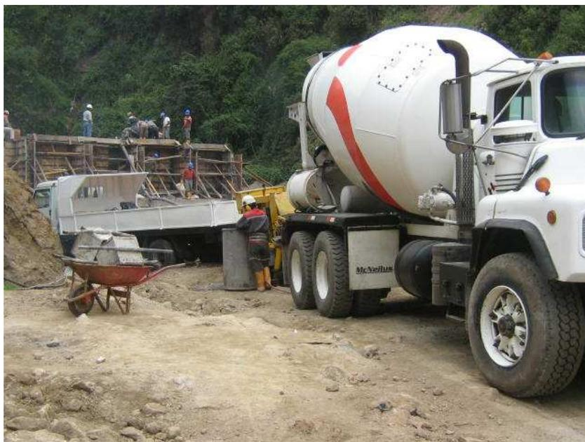
**Figura N° 32.- Ubicación de mixer y bomba de hormigón para fundación de paredes del dique**
