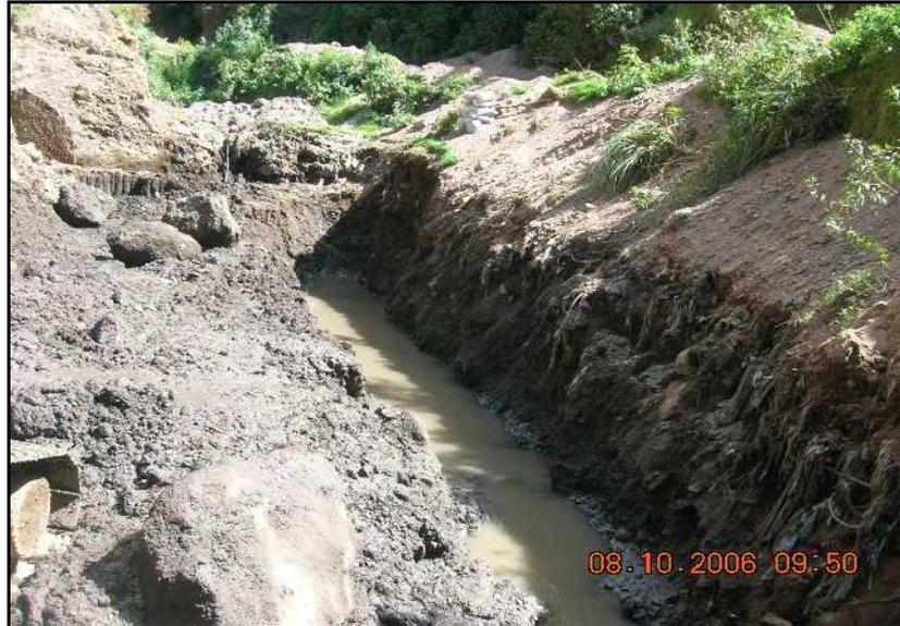
**Figura N° 23.- Canal para drenaje**
