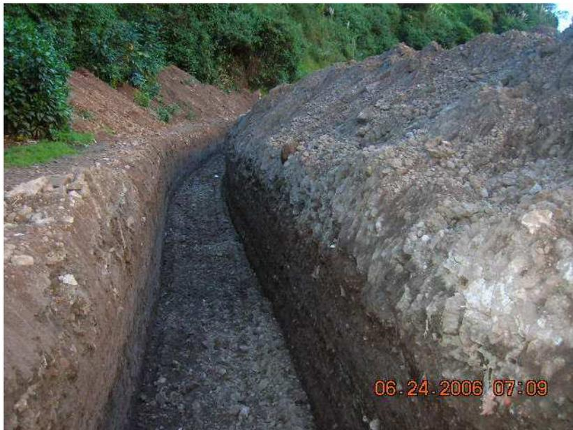
**Figura N° 10.- Canal excavado margen izquierda del dique aguas abajo, sección rectangular.**
