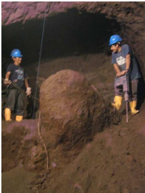
**Figura N° 74.- Frontón de excavación con deposito de rocas en cangahua.**
