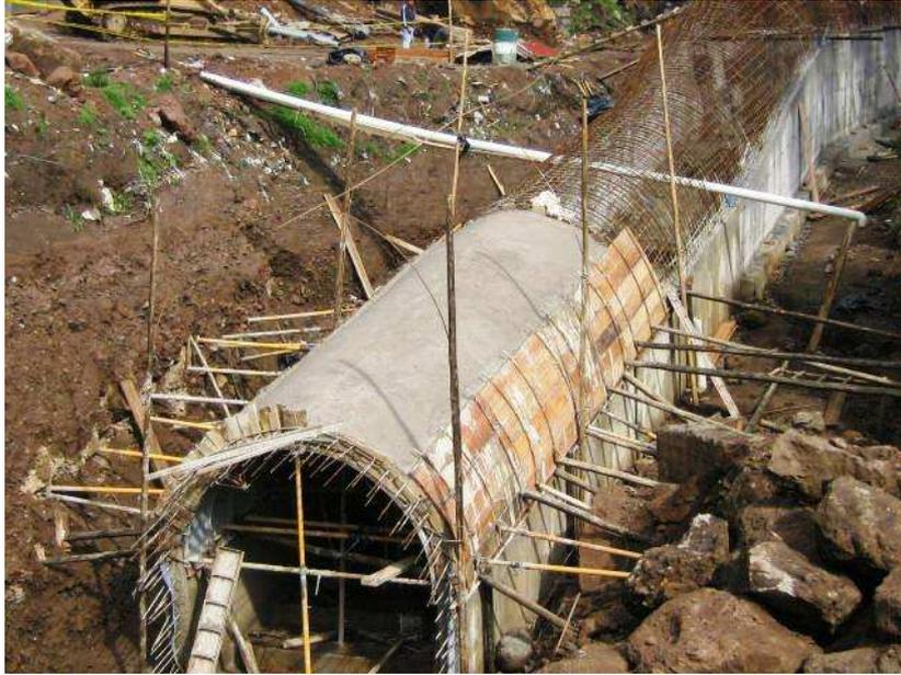
**Figura N°.- 46 sistema de encofrado externo en bóveda de colector a cielo abierto**
