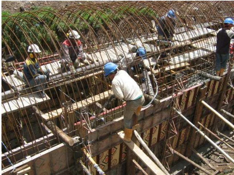
**Figura N° 44.- Colocación de andamio y vibrado de hormigón en paredes**
