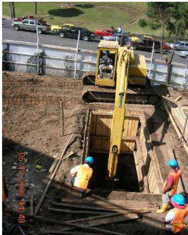
Figura N° 53.- Excavación vertical con retroexcavadora en pozo de avance PVM6'.
