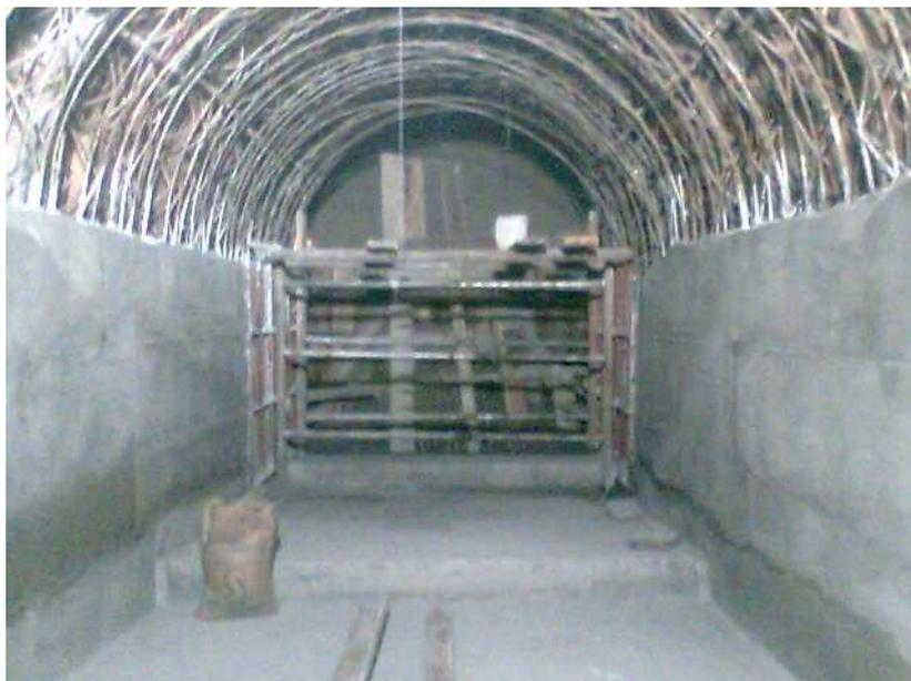
**Figura N° 88.- Sección revestida, solera y paredes**
