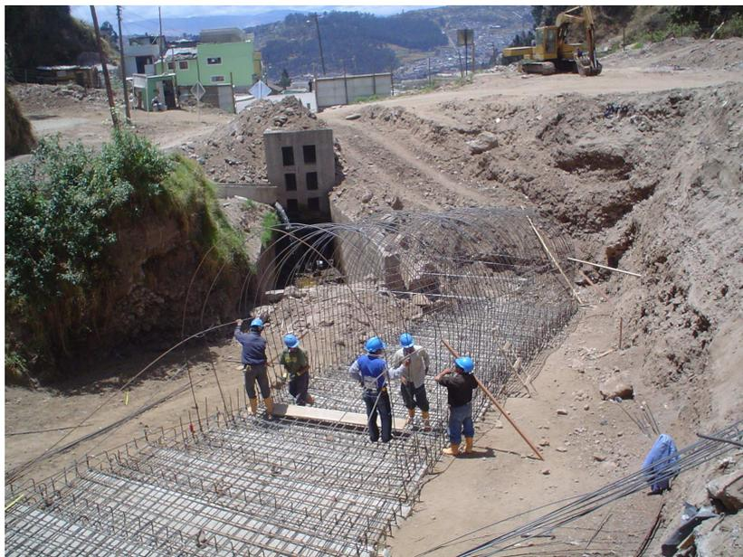
**Figura N° 41.- Armado estructural de paredes boveda desde la abscisa 0+086.32**
