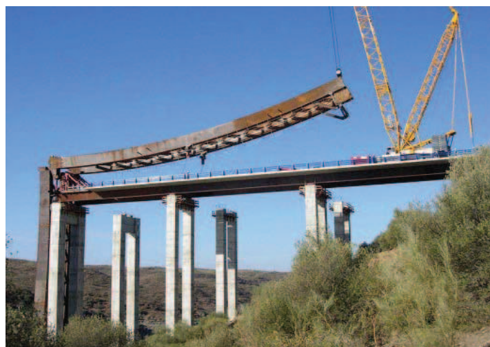
Figura 3.17 Basculamiento del cuarto de arco.
