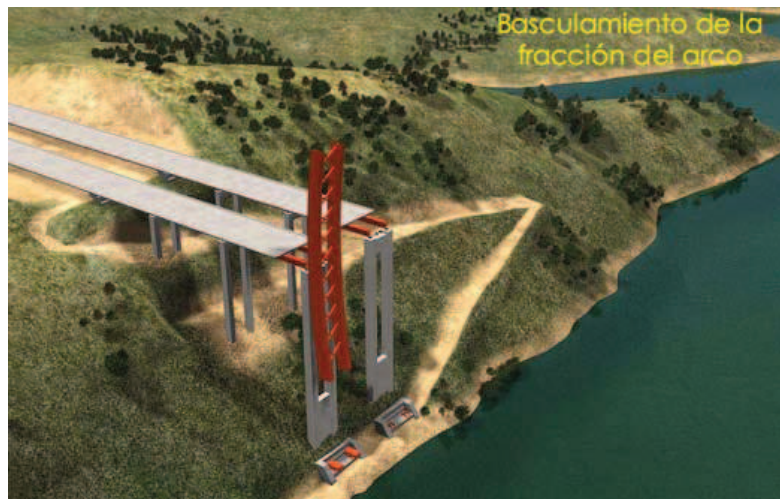
Figura 3.13 Basculamiento del \frac{1}{4} del arco.
