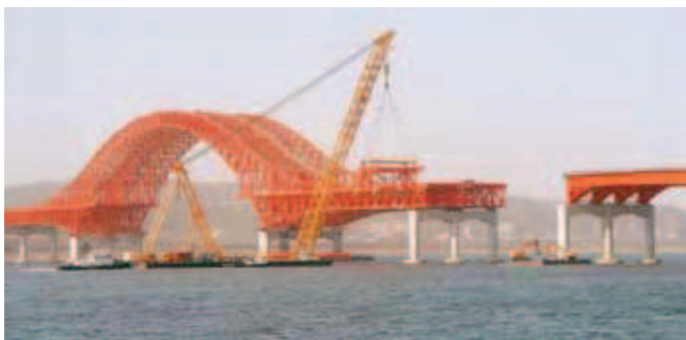
Figura 3.34 Construcción de los vanos de aproximación.
