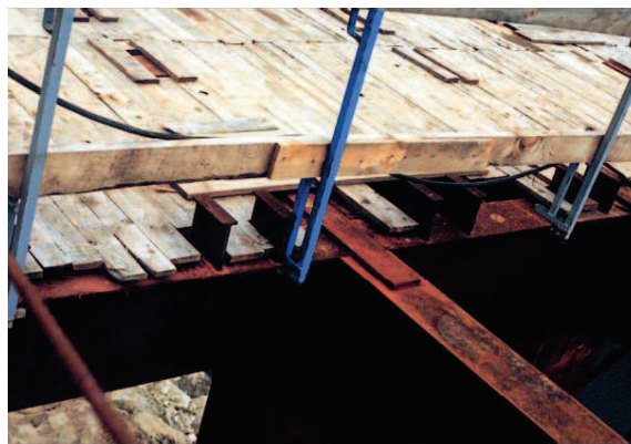
Figura 3.27 Vista del tablero provisional.
