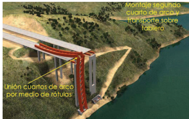
Figura 3.15 Montaje del segundo cuarto del arco.
