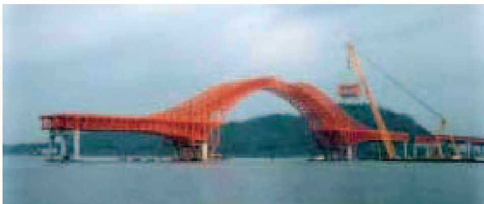
Figura 3.33 Colocación de la dovela central del arco.
