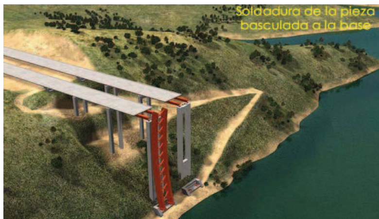
Figura 3.14 Soldadura una parte del arco a la base.
