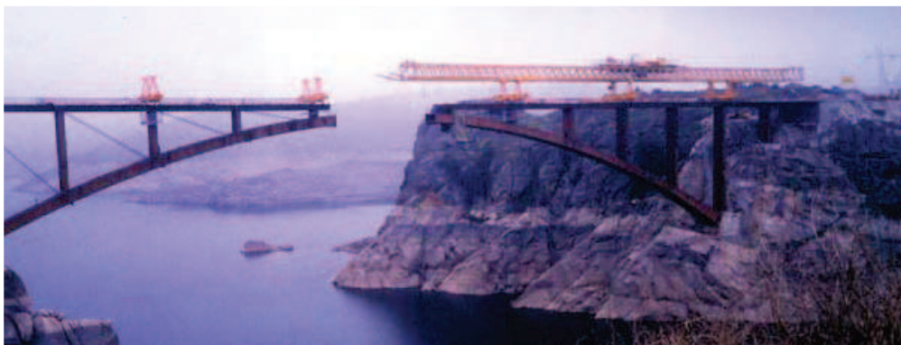
Figura 3.25 Avance de dos voladizos y la viga de lanzamiento de dovelas.
