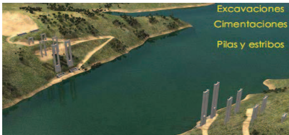
Figura 3.7 Excavación de los cimientos, pilas y estribos.
