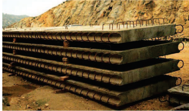
Figura 3.29 Losas prefabricadas del tablero de hormigón acopladas en obra.
