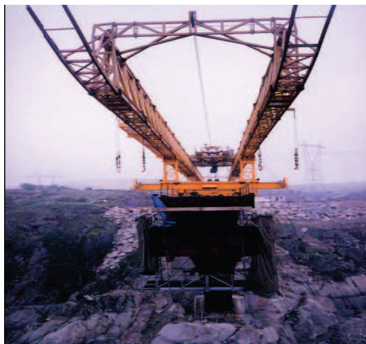
Figura 3.28 Lanzamiento y colocación de dovelas del arco.
