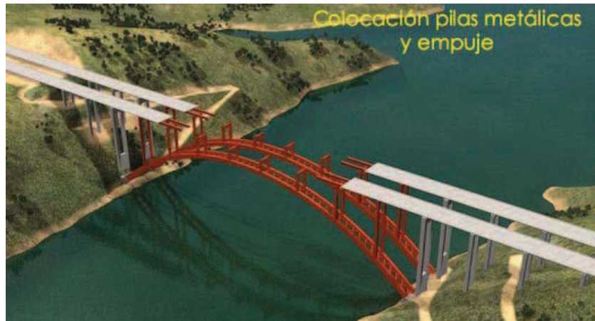
Figura 3.21 Colocación de pilas metálicas.
