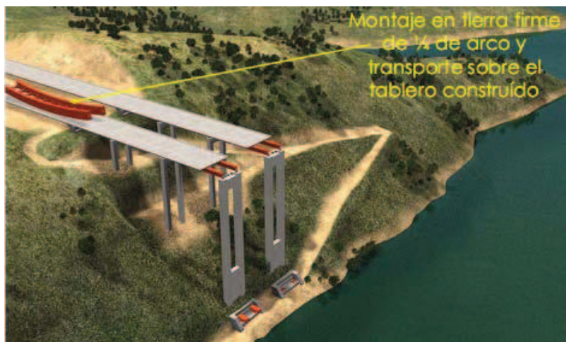
Figura 3.10 Montaje de \frac{1}{4} del arco.
