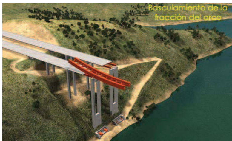
Figura 3.11 Basculamiento del \frac{1}{4} del arco.
