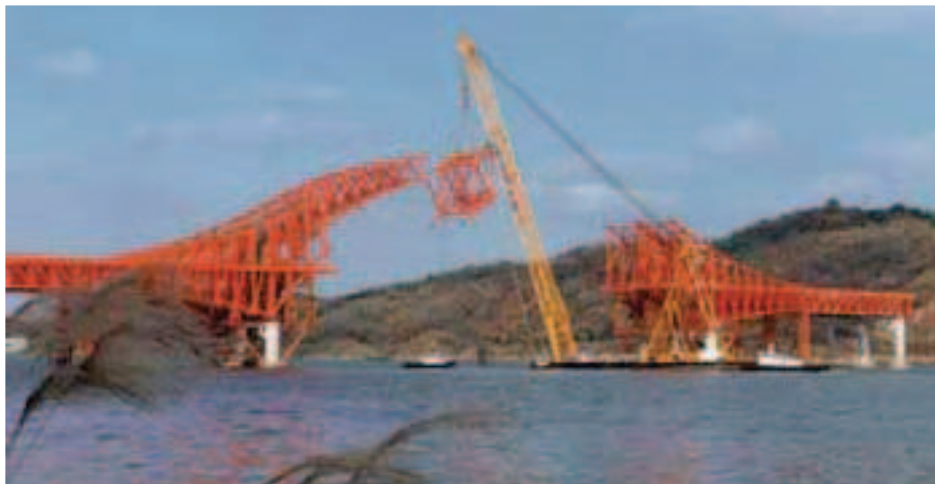
Figura 3.32 Colocación de dovelas del arco.
