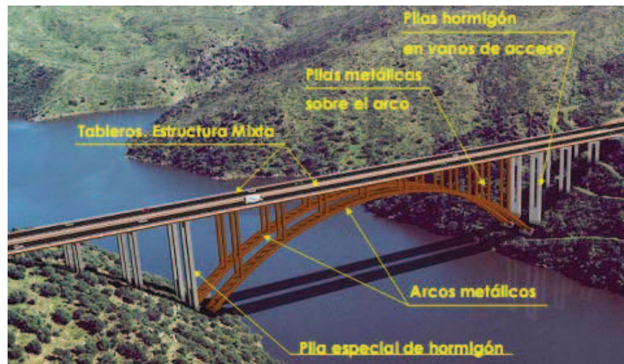
Figura 3.4 Elementos del puente
