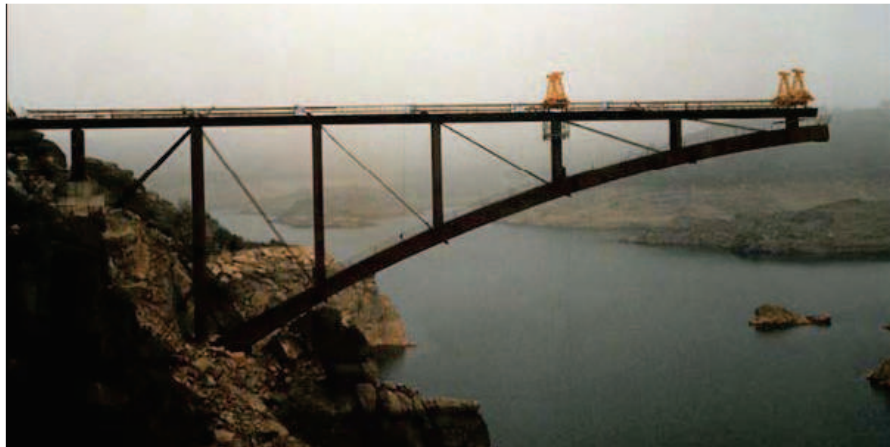
Figura 3.24 Arco en voladizo con tirantes a tracción.
