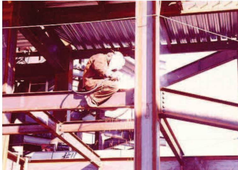
Figura 1.5 Soldadura de Estructuras Metálicas.
