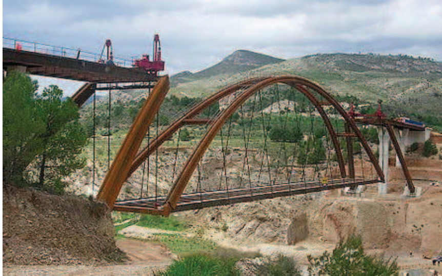
Figura 3.3 Izado del puente
