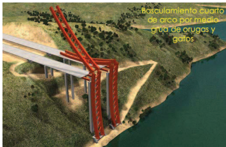
Figura 3.16 Basculamiento del cuarto de arco.
