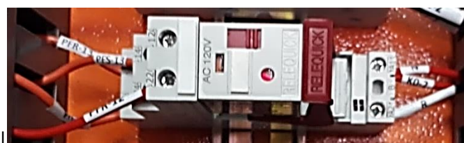
Figura 8. – Relés de pérdida de fase.
