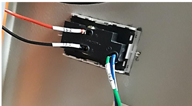
Figura 20. – Conexión de los tomacorrientes monofásicos.
