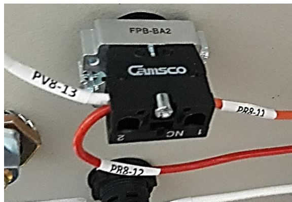
Figura 15. – Señalización de conexiones en los elementos.
