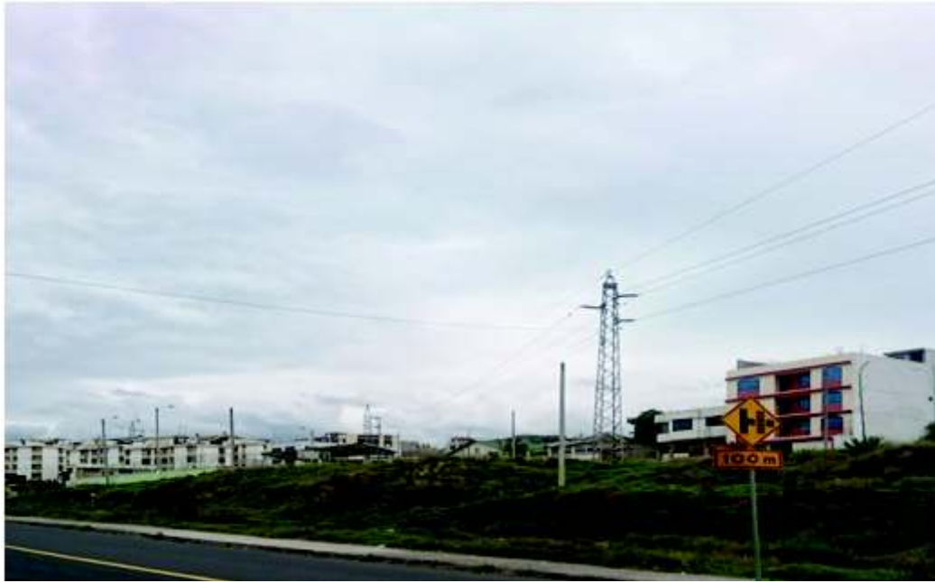
Figura 3.8. Estructura 268 EEASA con un solo circuito a ser modificado a doble circuito.
