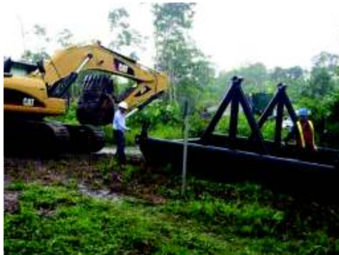
Figura 3.19. Tendido de cables mediante el método de carrete móvil [20].
