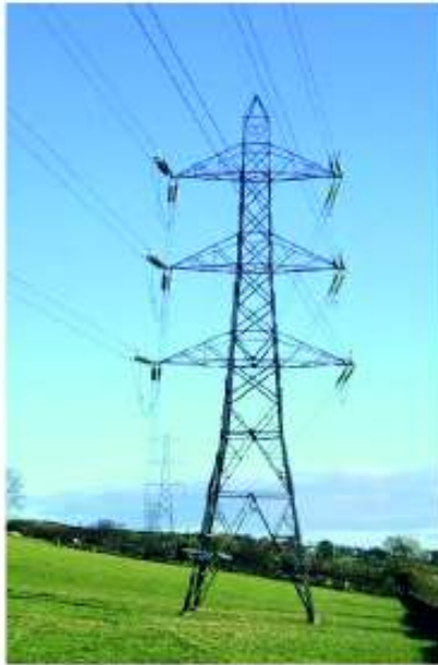
Figura 2.10. Torre de Retención [6].
