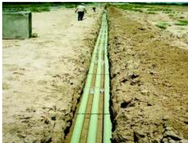
Figura 2.17. Zanja y Banco de ductos para 3 cables [15].
