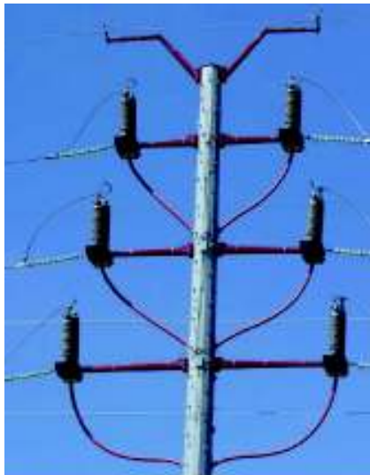
Figura 2.18. Transición aérea-subterránea a 69 kV [18].
