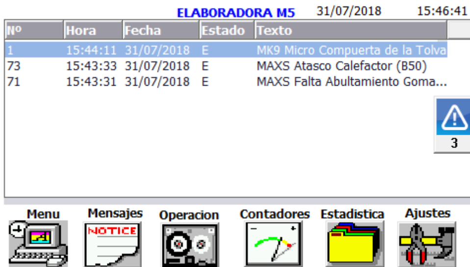
Figura 3.11 Prueba en la Pantalla de Alarmas.
