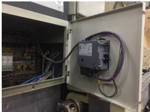
Figura 2.8 Instalación del cable de alimentación y red para el panel KTP400.
