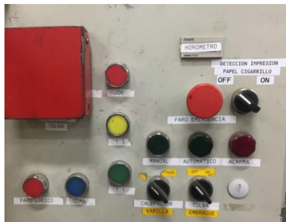
Figura 2.6 Puerta Aledaña al Panel Táctil.
