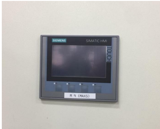
Figura 2.7 Panel KTP400 Instalado en la Nueva Puerta.
