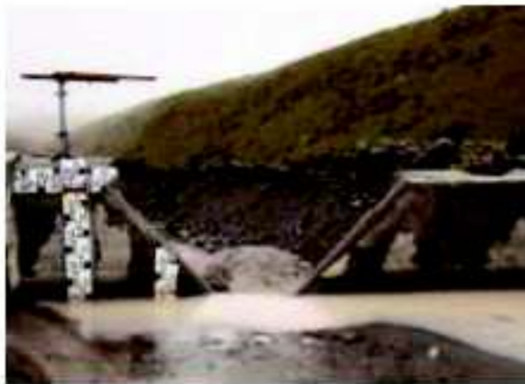
FIGURA 4.3: VERTEDERO TRAPEZOIDAL LOS CRESPOS A 4521 M.S.N.M.
