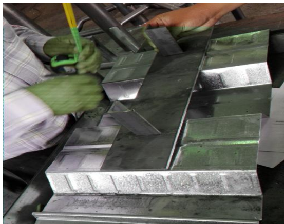
FIGURA 4.7 Ubicación del patín de la viga tipo “I” sobre la lámina deck.
