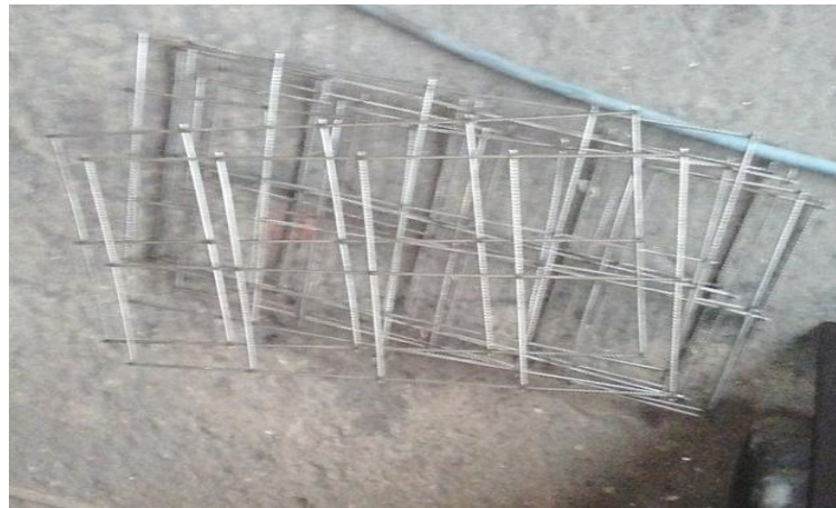
FIGURA 4.6 Corte malla electrosoldada con cizalla.
