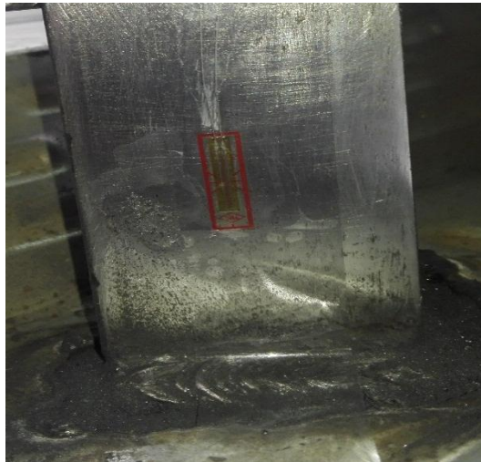
FIGURA 4.31 Instalación strain gauges en el acero.
