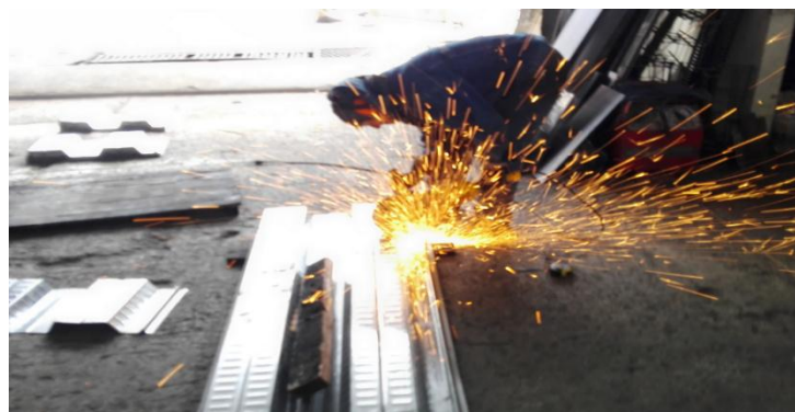
FIGURA 4.3 Corte lámina deck.
