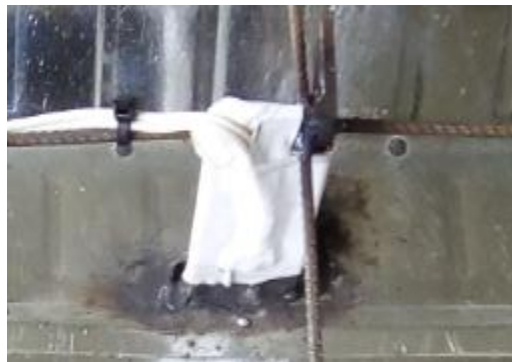
FIGURA 4.39 Instalación protección strain gauges.
