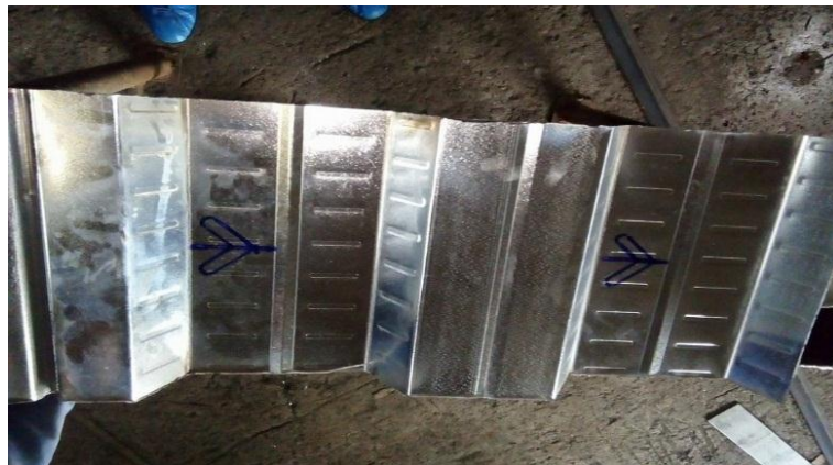
FIGURA 4.4.9 Marca conectores de corte a 45°.
