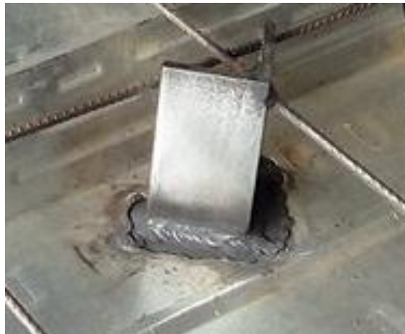
FIGURA 4.28 Superficie lijada en el conector de corte.
