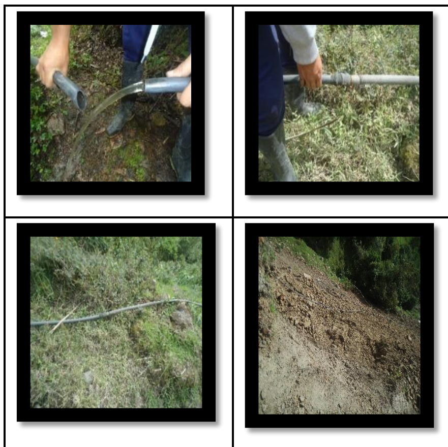
FIGURA 26 ESTADO DE LA RED PRINCIPAL
