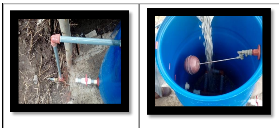
FIGURA 14 MONTAJE DEL FLA
