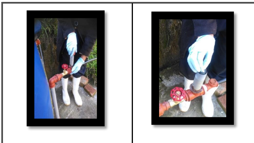
FIGURA 24 UBICACIÓN DE LA PASTILLA DE CLORO EN EL CLORADOR
