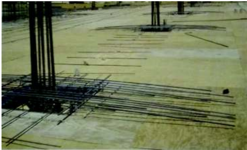
Figura 2. 12 Refuerzo superior en el capitel de hormigón.
