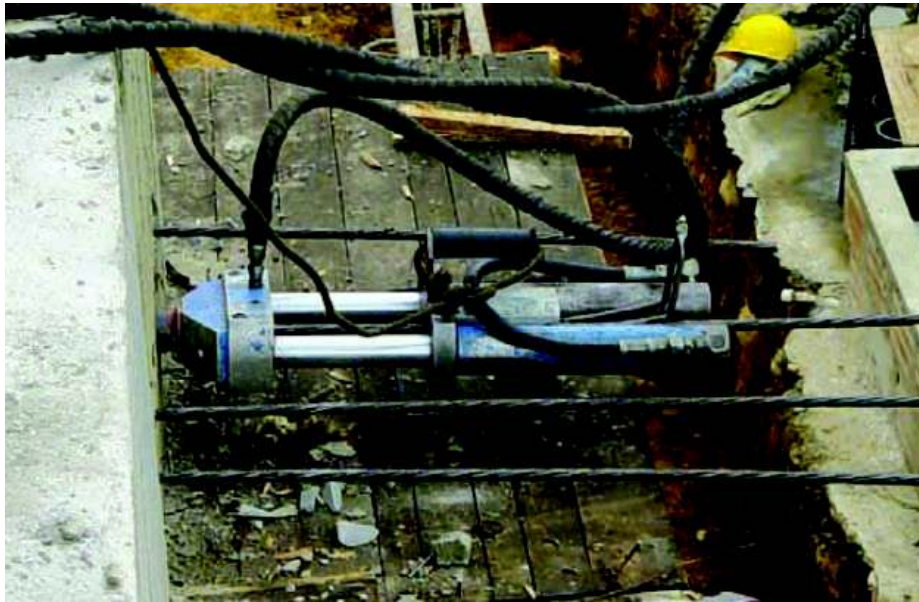
Figura 2. 5 Gato Hidráulico (JACK).
