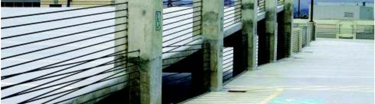
Figura 1. 12 Cable de barrera
