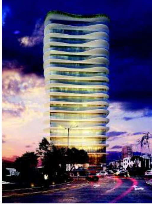
Figura 1. 13 Edificio YOO Quito. U&S
