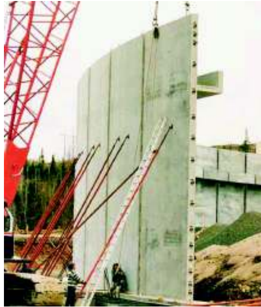
Figura 1. 8 Tanque de almacenamiento.
