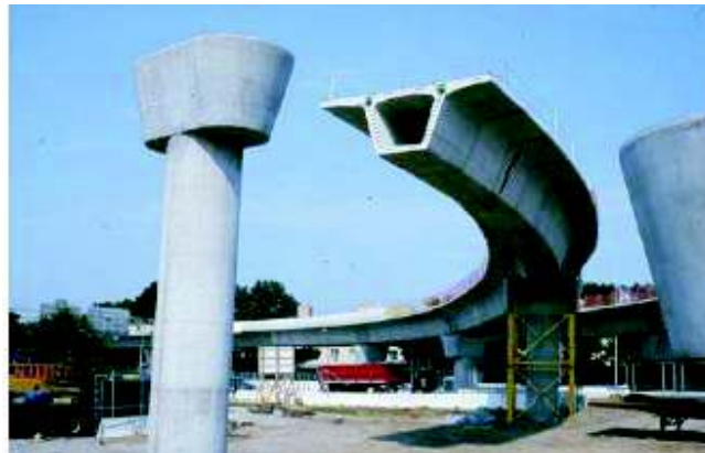
Figura 1. 7 Puente en hormigón postensado.
