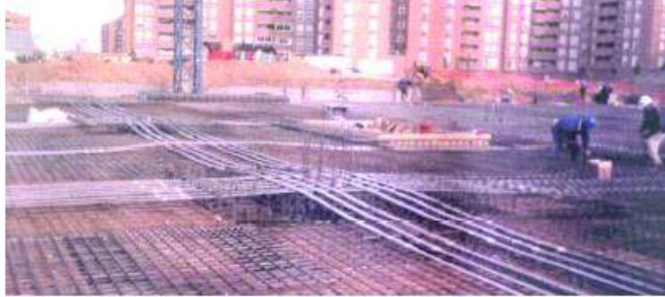
Figura 1. 6 Losa de cimentación en hormigón postensado.
