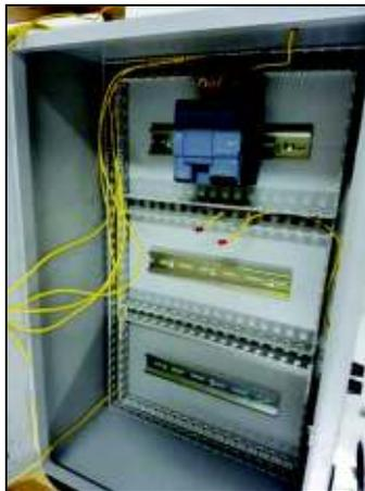
Figura 3.17 – Ubicación de canaletas para el cableado interno
