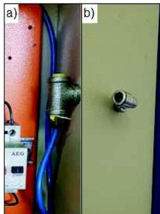
Figura 3.57 – Toma de aire del gabinete del sistema de nivel
