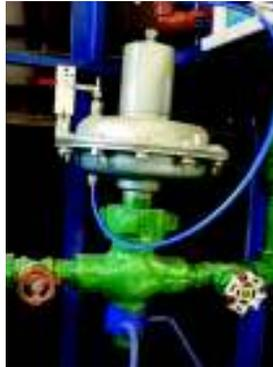
Figura 3.50 – Válvula de control tipo globo 2220
