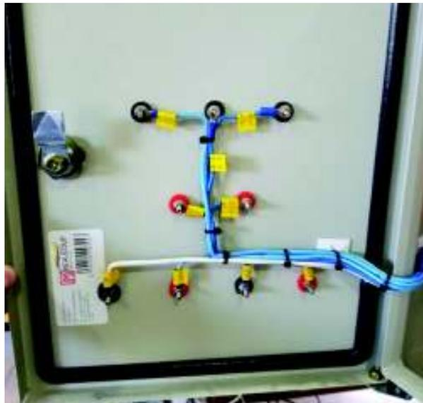
Figura 3.60 – Etiquetado y organización del cableado de nivel
